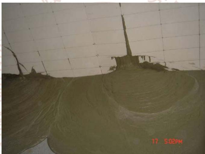
圖 3-28 灌入發泡水泥後隔板下方繃裂漿體外流
