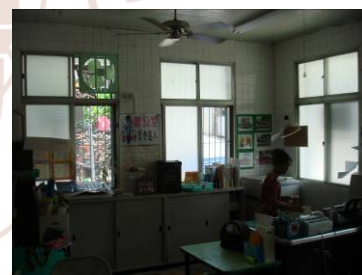
教室內平均照度不足
