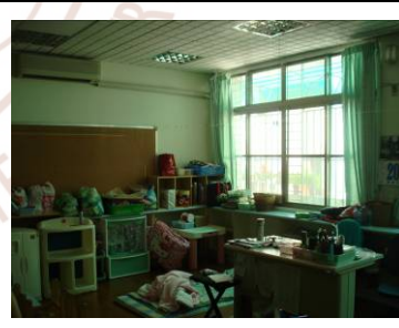
教室晝光使用不佳,均齊度不良
