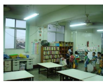
教室無吸音材料，噪音嚴重
