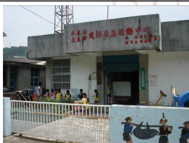
托兒所外觀, 建築體較老舊
