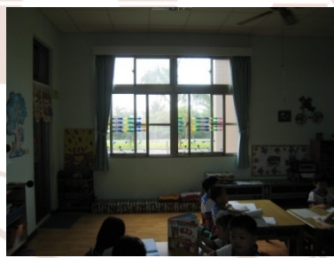
室內照度不足。
