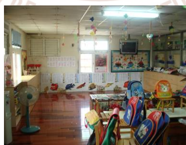
教室缺乏吸音材料，反射率大，聲音能量無法消除
