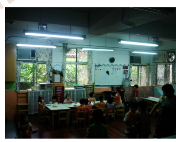
教室作業面照度不足，均齊度欠佳
