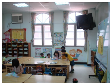
C 區室內無機械排風設備，空氣停滯
