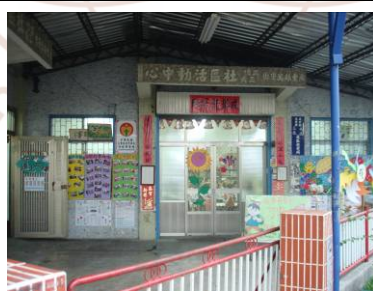
半戶外遊戲區現況，缺乏燈具輔助，照度不足
