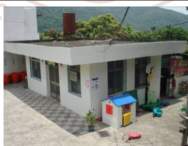
托兒所外觀, RC 單棟平屋頂
