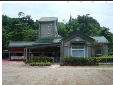
托兒所外觀，外部有大片植草磚空地
