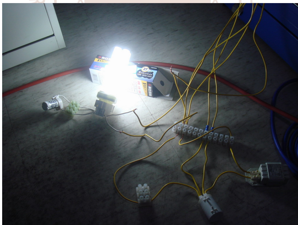
圖 4-59 PL 型螢光燈管排除安定器性能測試圖
