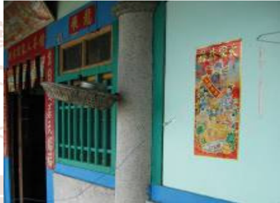
附圖22淺色木板外牆吸收率0.5，平均表面溫度32.3°C
