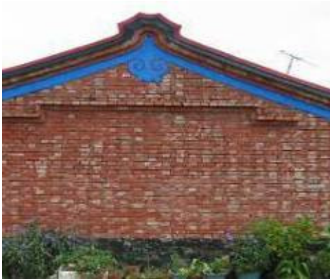
附圖21磚牆吸收率0.77，平均表面溫度36.5°C
