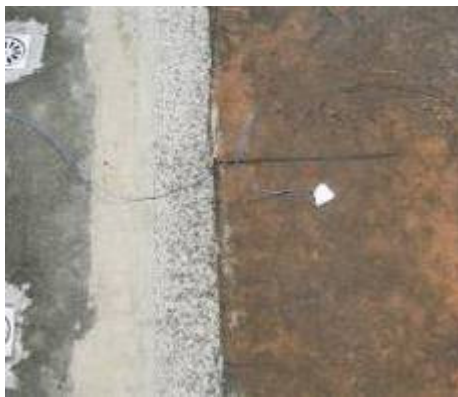
圖23 面磚吸收率0.73，平均表面溫度49.1°C
