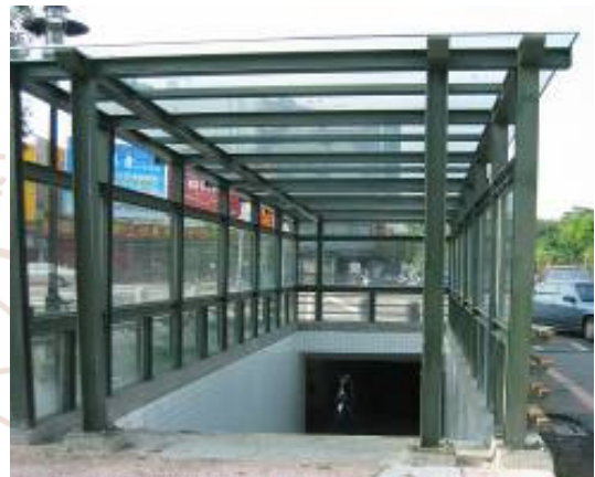
圖26 透明玻璃遮罩吸收率0.06,透射率0.9 平均表面溫度38.2°C,平均MRT37.9°C
