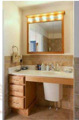
洗手台下宜考量膝蓋容納空間，且外露水管線應有隔離設備。
