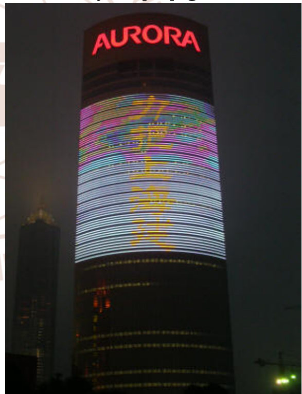
圖 3-1-1-4 上海外灘震旦行大型廣告 看板 LED 光電帷幕牆 (右側) 資料來源： http:// skyscraperpage.com/
