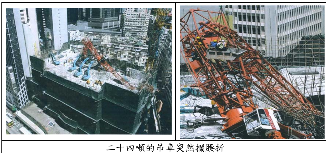
圖 4-2 銅鑼灣吊架折斷
