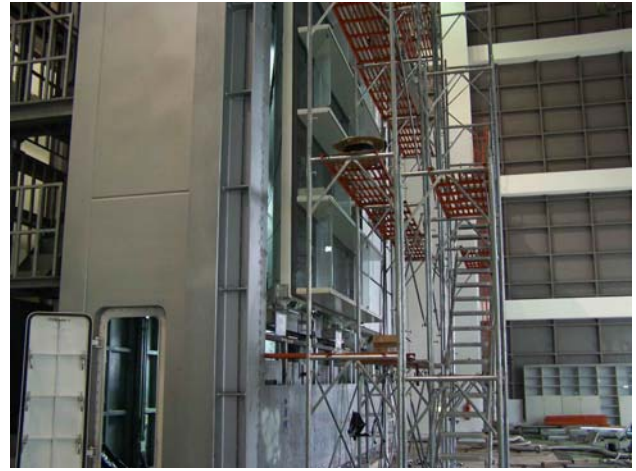
圖 3-3-12 施工鷹架 (資料來源：本研究整理)
