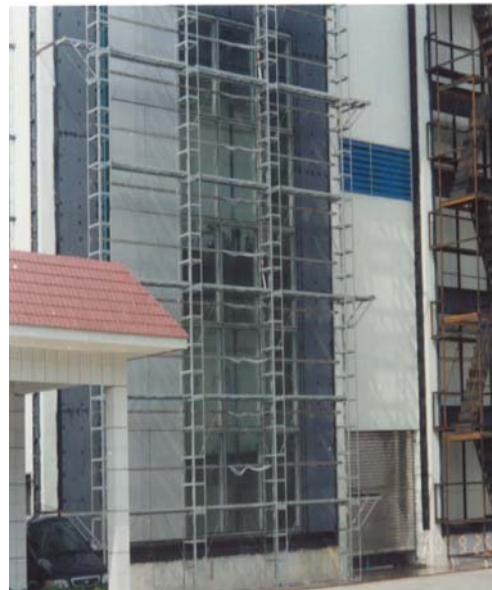
圖 2-5-2 兆閃試體安裝完成 (資料來源：陳文祈(2001), 內政部建築研究所)
