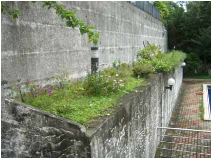
照片 5-5 案例一 C 擋土牆外觀
