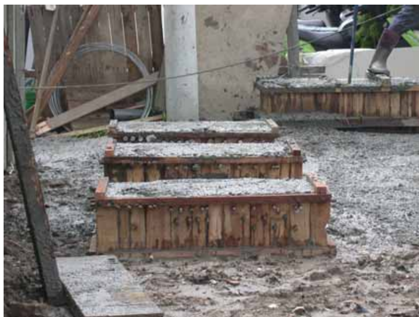
擋土牆混凝土模型
