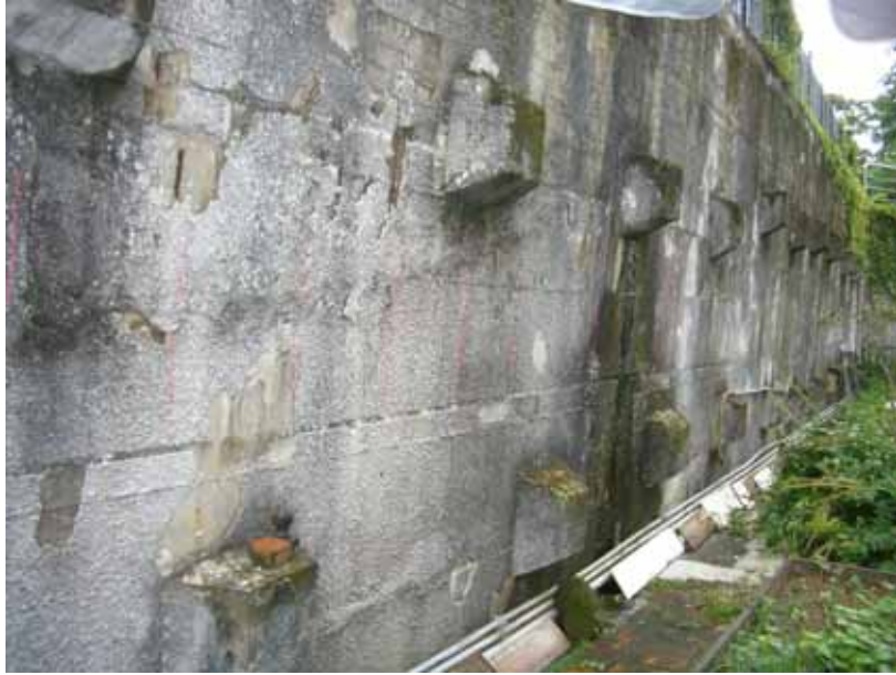
照片 5-4 案例一 B 擋土牆外觀
