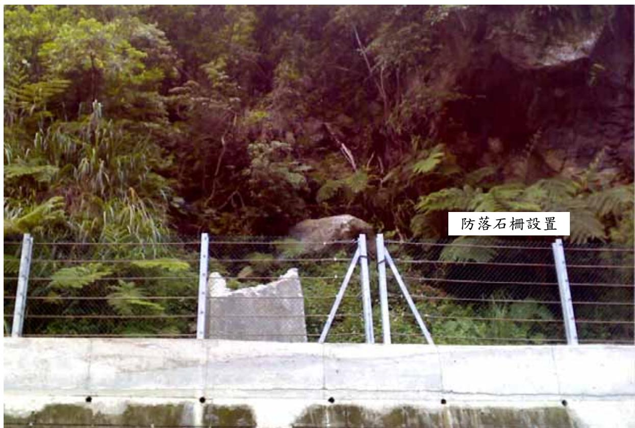
圖 5-5 石碇一民房建築物前之防落石柵設置(上：設置前，下：設置後)
