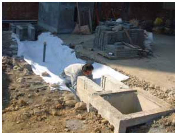
圖 4-2 不織布鋪設概況
