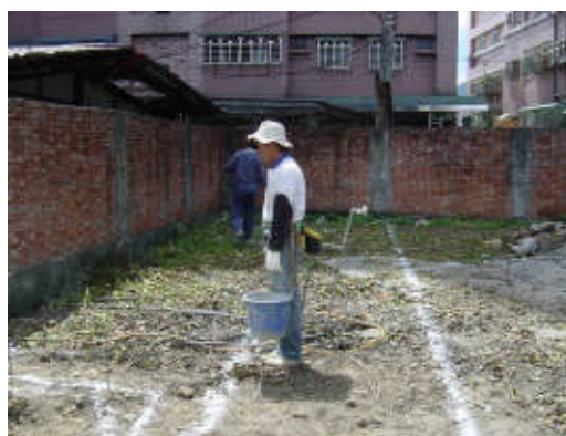
(b) 滲透側溝試驗模型放樣概況
