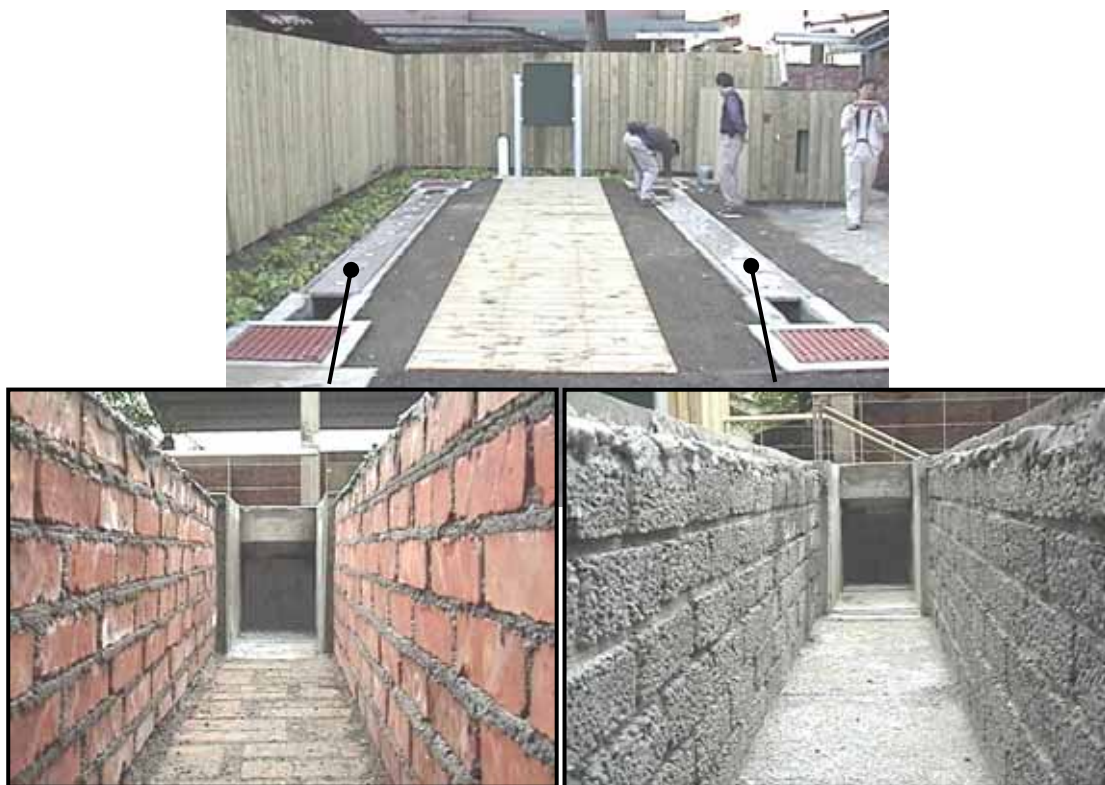
圖 4-4 透側溝完工後概況
