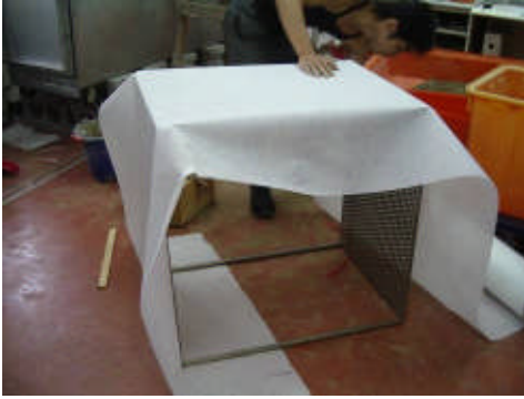
(h) 管溝設置槽不織布鋪設
