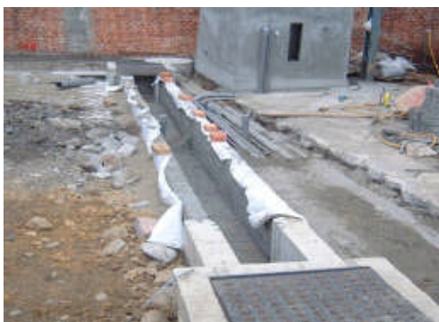
(c) 透水磚側溝鋪設不織布級配後概況
