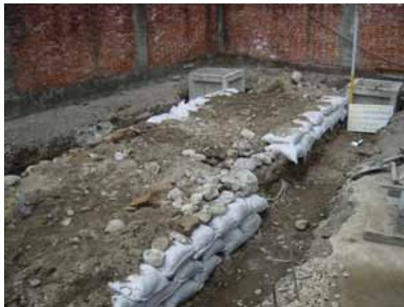
圖 4-1 滲透側溝開挖概況
