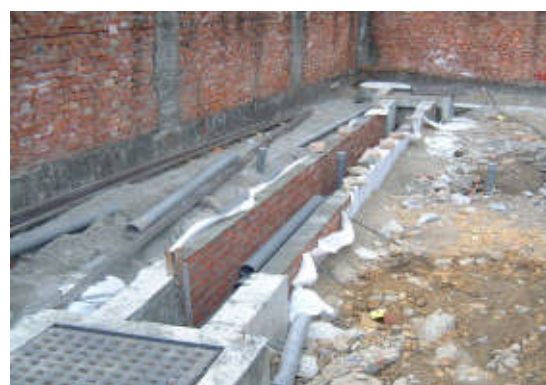
(d) 紅磚側溝鋪設不織布級配後概況
