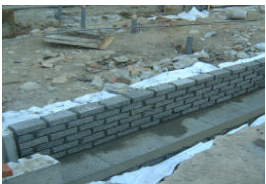
(c) 透水磚側溝鋪設不織布級配後概況
