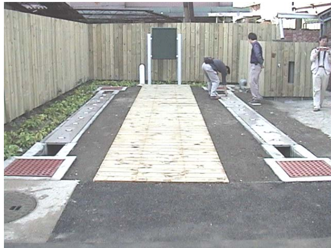
圖 3-8 具實驗與示範性質的滲透測溝
