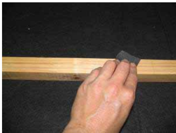
圖 3-11 去除劣化層（砂磨）
