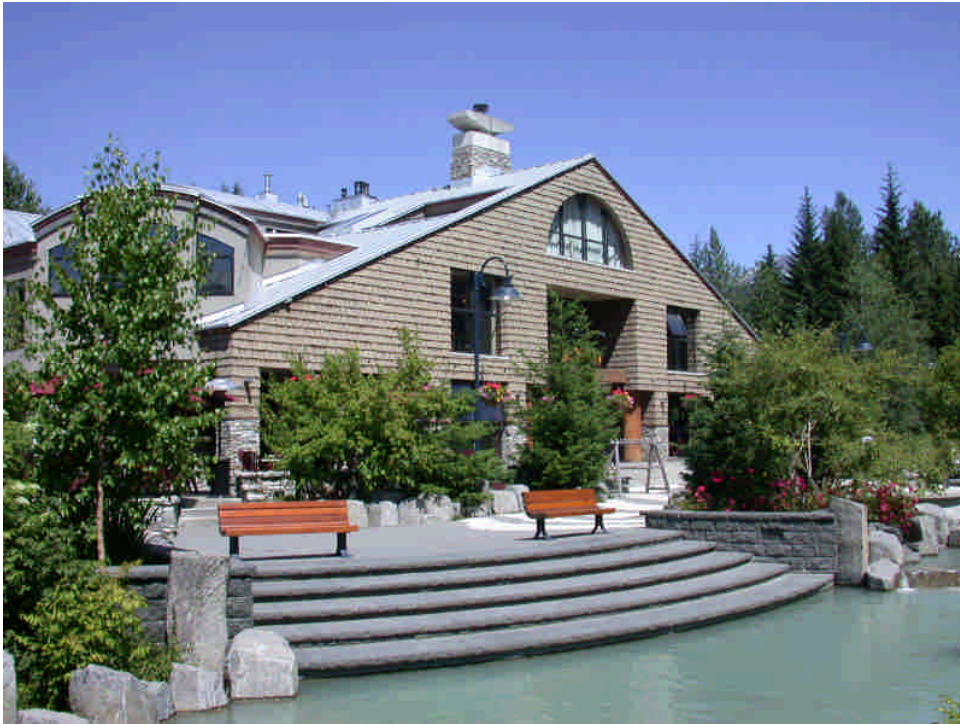
照片 5 惠思勒鎮遊憩區餐廳（木造建築）
