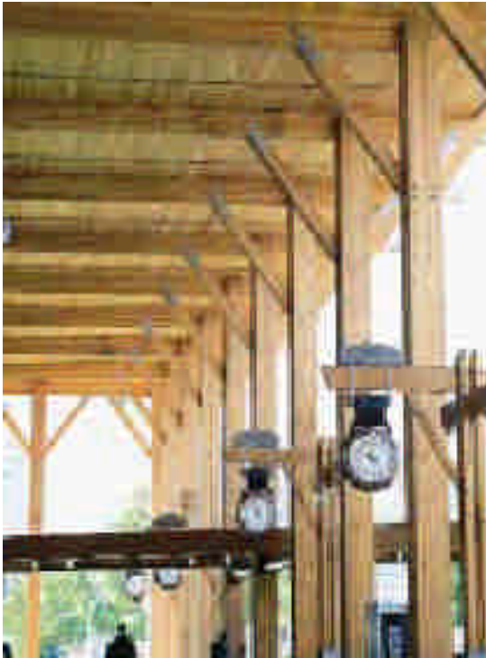
(a) 入口處膠合材支柱
