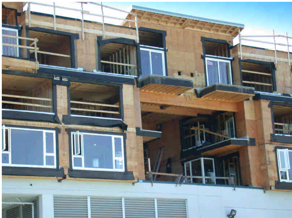
照片 2 溫哥華市區興建中木造四層連棟住商混合式街屋（二樓以上供住宅使用）
