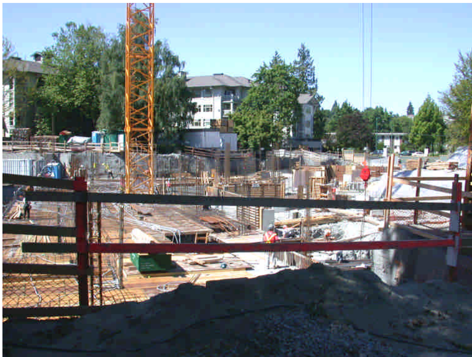
照片 3 溫哥華市區大面積木造公寓興建工地 (RC 基礎工程作業中)
