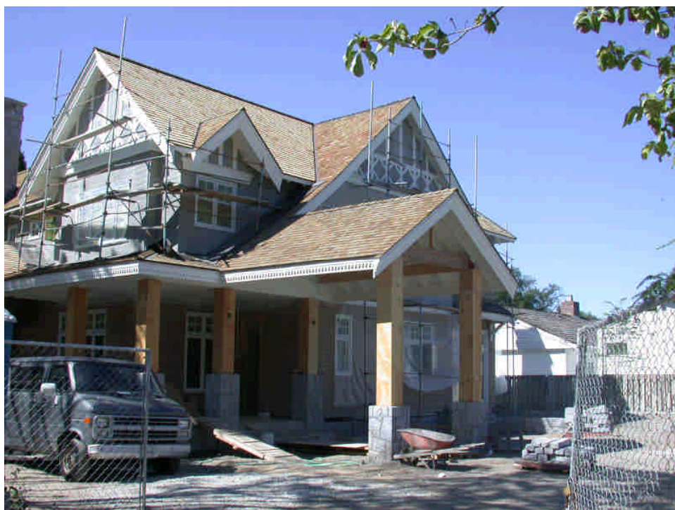
照片 4 溫哥華市區高級住宅區興建中柱樑式木構造豪宅工地
