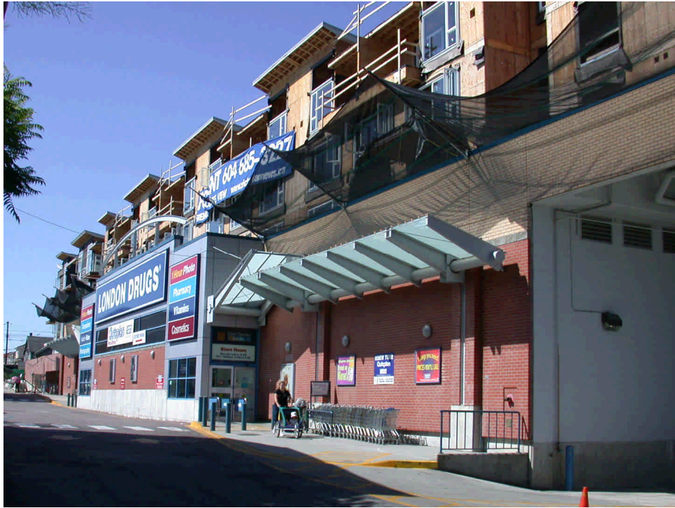
照片 1 溫哥華市區興建中木造四層連棟住宅-商店混合式街屋（一樓 RC 造）
