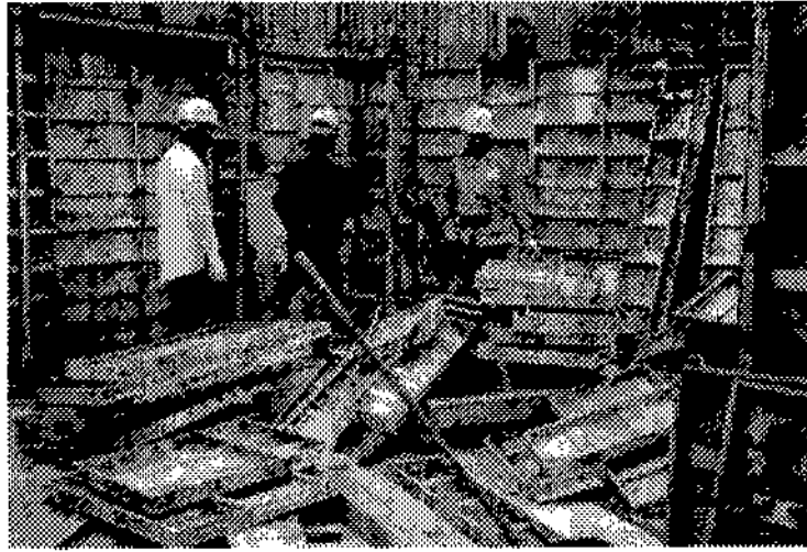
圖 3.7 現場施工現況
