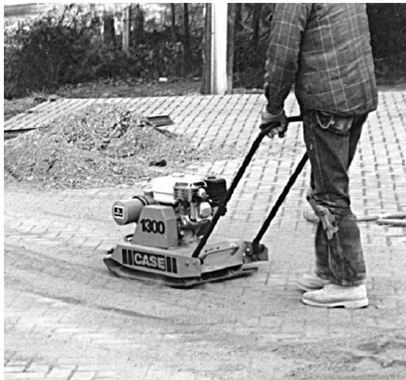
圖5-20 透水磚鋪面面層夯實
