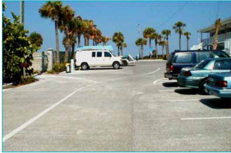
圖2-9 美國多孔隙瀝青混凝土應用於停車場鋪面
