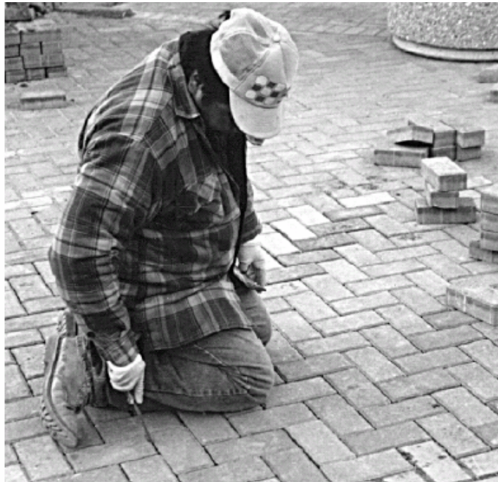
圖5-19 透水磚鋪面接縫調整與確定
