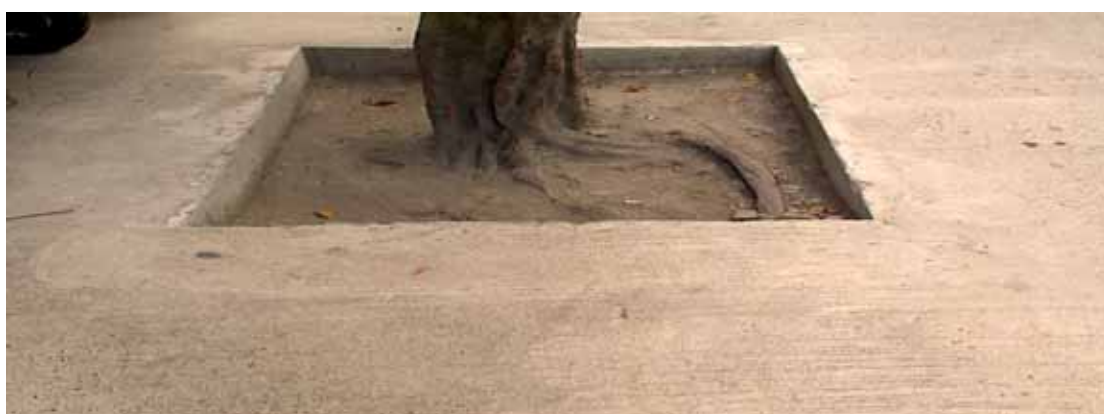
圖2-14 純混凝土鋪面
