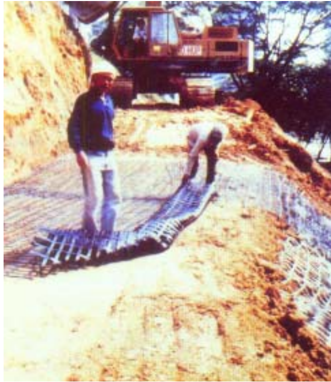
圖6.4 加勁擋土牆施作情形
