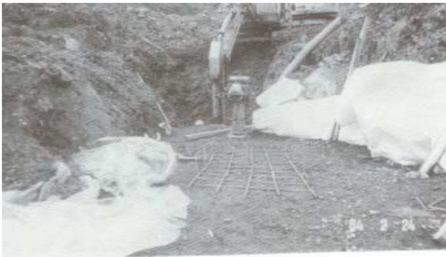
圖 5.4 排水盲溝施工情形
