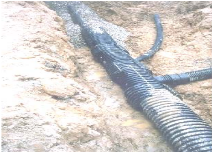
圖 5.2 地下排水盲管
