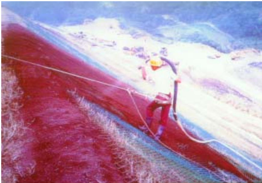
圖 4.5 掛立體網噴基材工法施作情形
