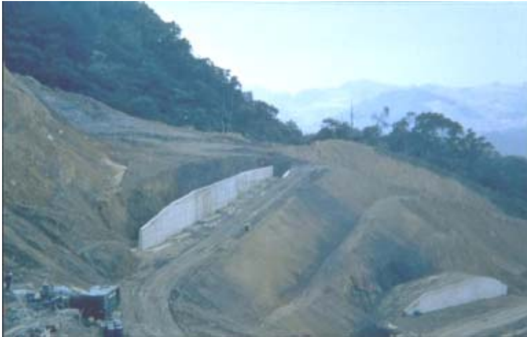
圖 6.13 填方地區擋土牆完成
