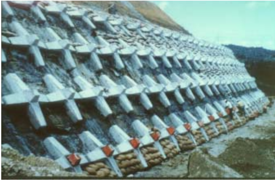
圖 6.9 格梁擋土牆
