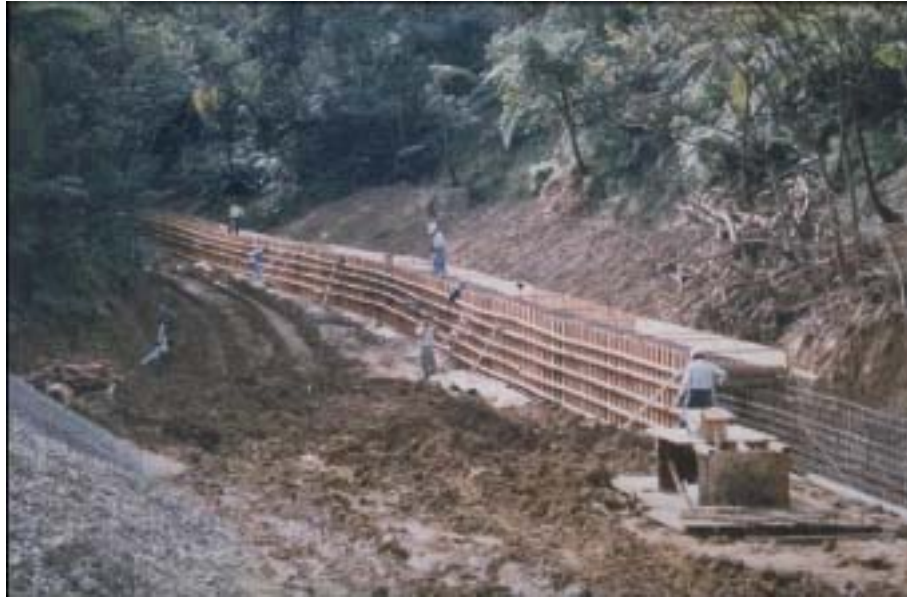
圖 5.5 地下盲溝施工情形
