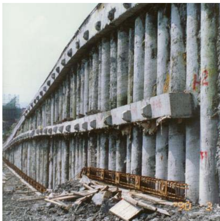
圖 9.3 排樁加地錨擋土設施
