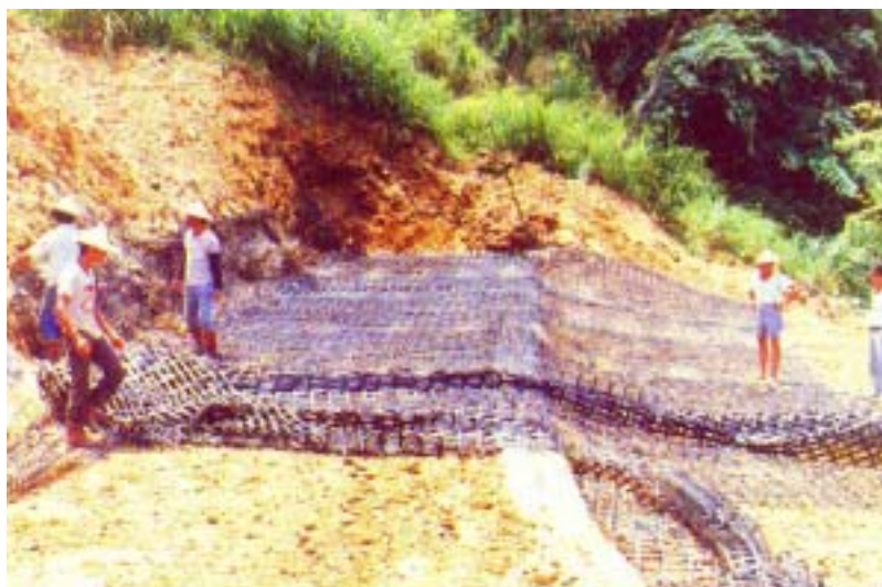
圖6.3 加勁擋土牆施作情形
