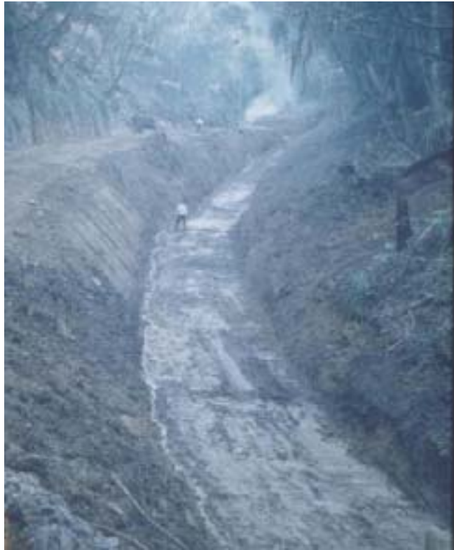
圖 5.3 排水盲溝施作前清理情形
