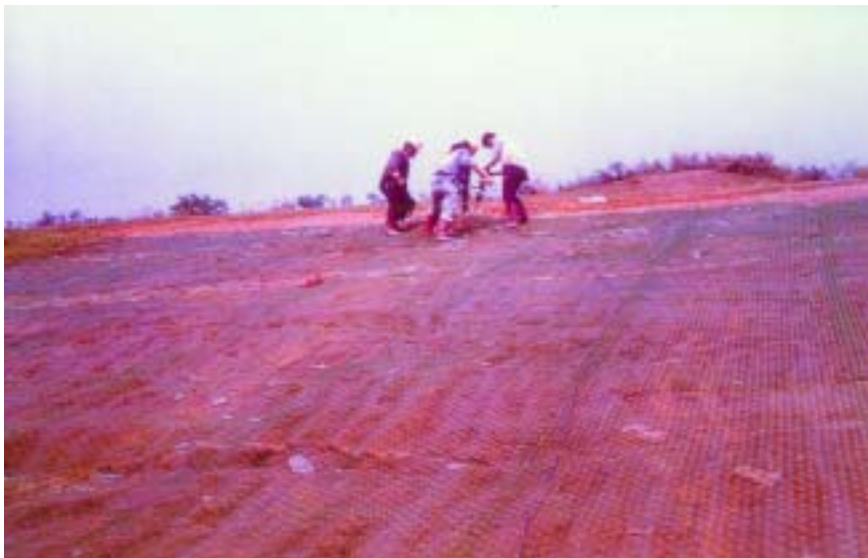
圖 4.4 坡面覆蓋噴植情形
