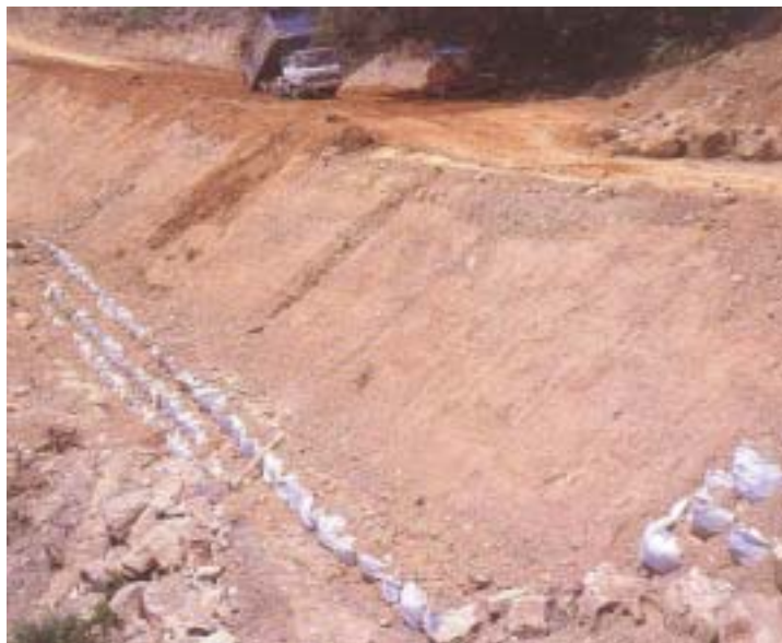
圖7.5 道路路基施築
