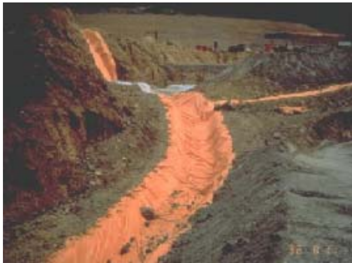
圖7.6 簡易土溝外鋪PE布
