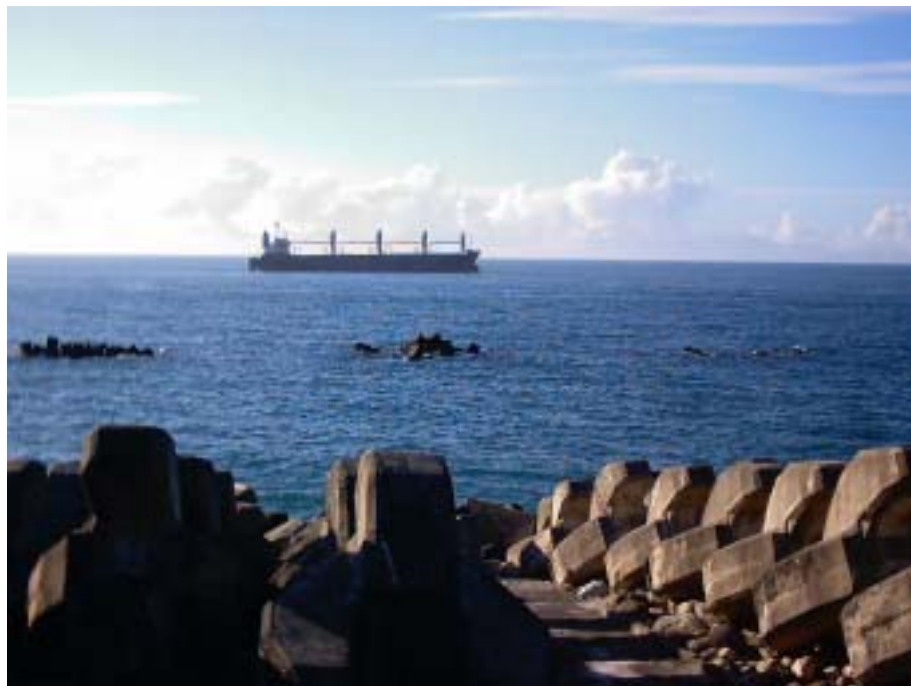
圖 3.73 再生混凝土消波塊的產品應用例情形
