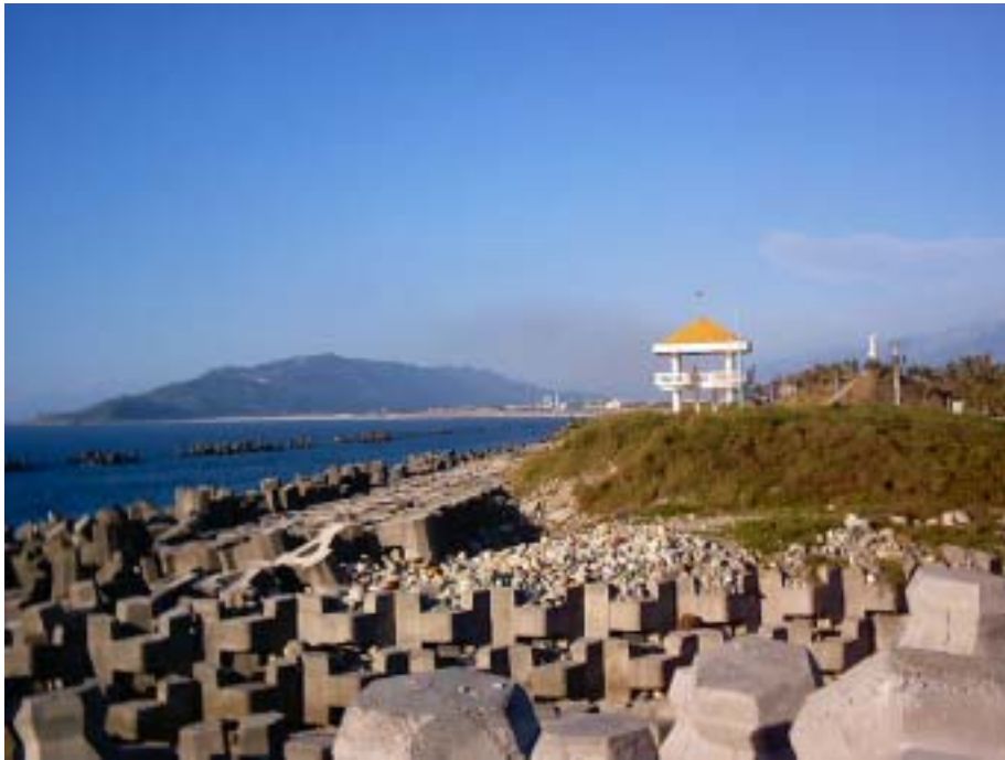
圖 3.72 再生混凝土消波塊的產品應用例情形
