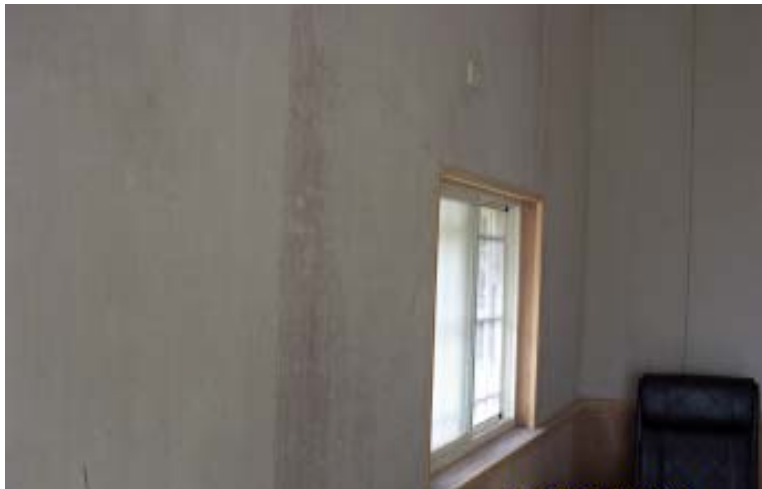
圖 3.54 再資源化水泥纖維板應用於室內隔間板試驗情形
