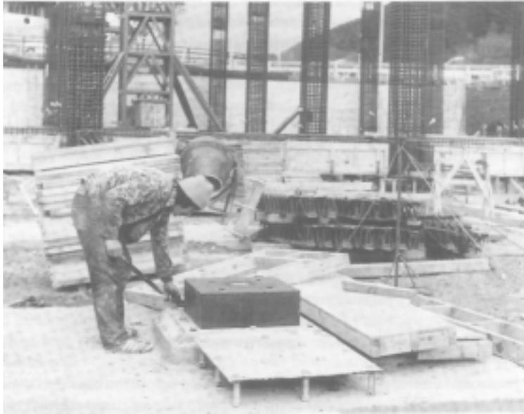
圖 A-8 建造中的威廉克雷頓大樓，注意鉛芯膠支承
