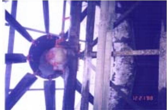
圖 5-20 冷卻塔之螺旋槳風扇
