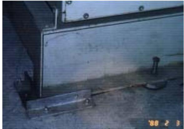
圖 5-2 發電機底部止震器與防振裝置
