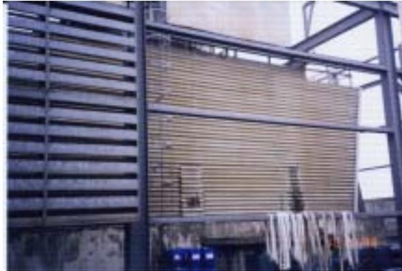
圖 5-19 冷卻水塔及其隔音牆
