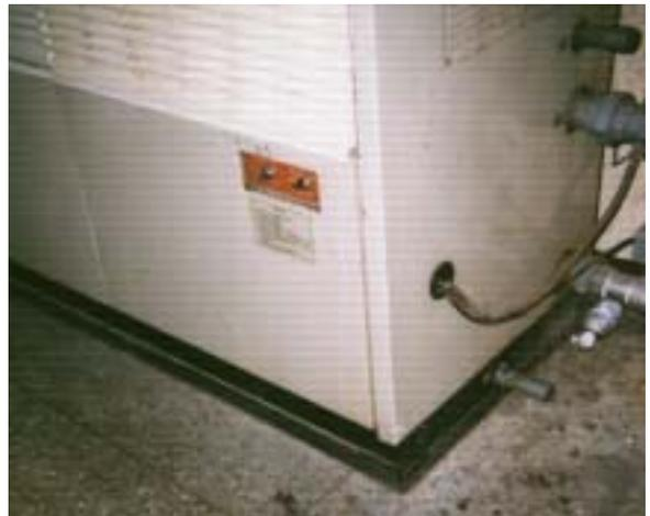
圖 5-22 箱型冷氣機底部防振墊
