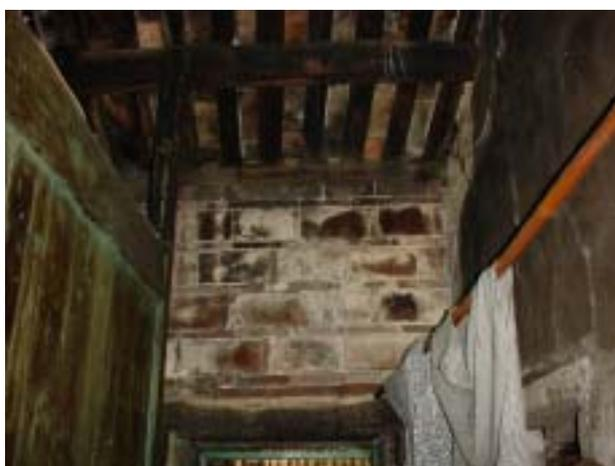
圖 2-3-5 閩南磚與木造的混合式構造
