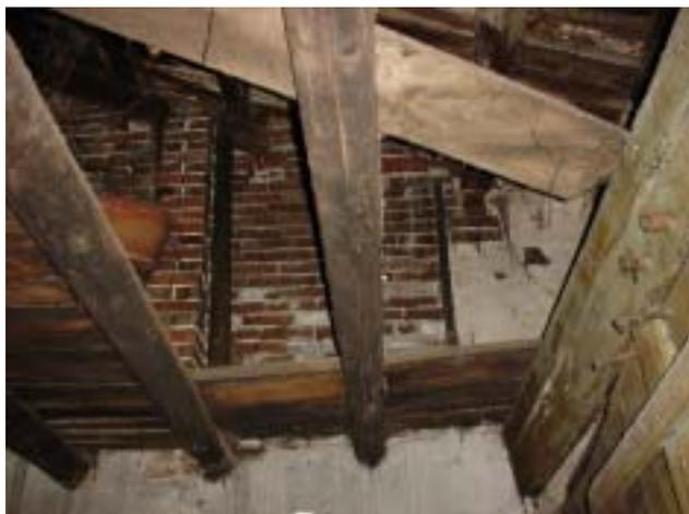
圖 2-3-4 閩南磚與木造的混合式構造
