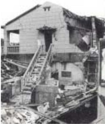
【照片 4-2-107】左側山牆牆體破裂崩塌，且沿開口部邊緣、山尖與木桁接合處產生開裂。
