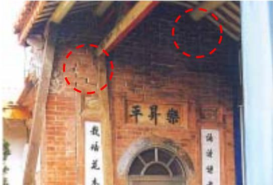
【照片 4-1-1】磚牆與木桁的接合處產生壁體出現裂痕（南投張烏牛欄黃宅）
