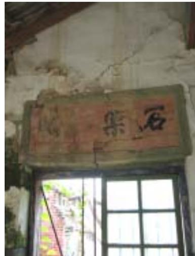
【照片 4-2-57】在右側山牆的窗楣，中央產生一道開裂並造成些微下沉。
