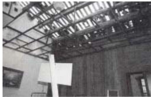
【照片 4-2-100】明間屋面破損，屋瓦掉落。
