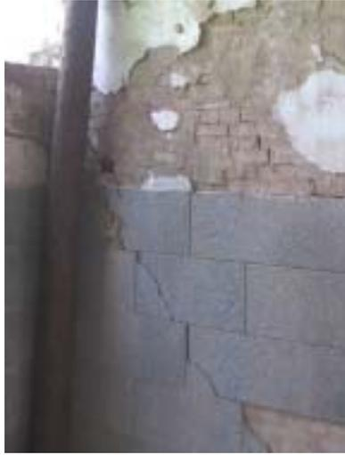
【照片 4-2-62】左側山牆與後簷牆相接的牆角，出現一道斜向的開裂。
