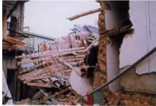
【照片 4-1-26】從與木樑接合點處產生壁體破裂，導致土角牆坍塌（大里陳宅善慶堂）
