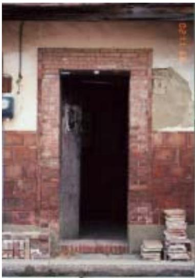
【照片 4-2-21】磚砌門框與土角牆間有大片粉刷層剝落
