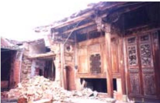
【照片 4-1-6】附壁屋架傾斜與牆體脫開
