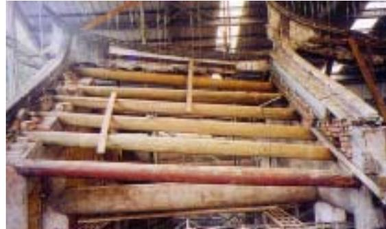
【照片 3-1-5】大堂的次間其棟架抽換為 RC 柱樑結構
