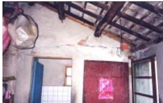
【照片 4-1-2】磚牆與木桁的接合處產生壁體出現裂痕
