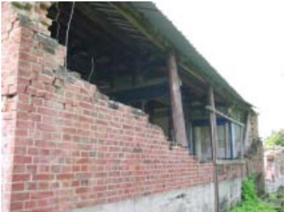
【照片 4-2-46】正廳的後簷牆上，整個牆面產生一道兩側較高而中間較低的彎曲斷面，斷面上半部已倒塌下半部牆體則依然保持完整。
