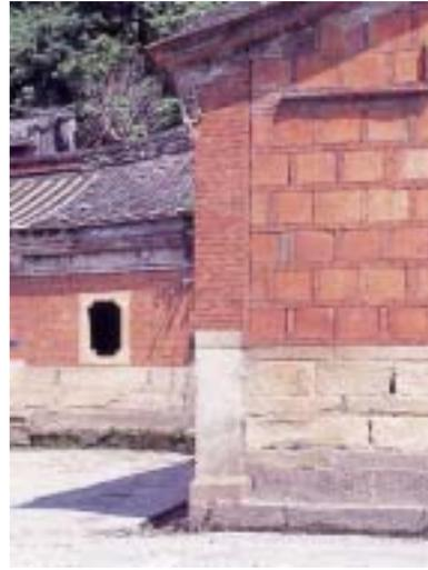
【照片 3-1-14】磚砌角柱下方接石柱基
