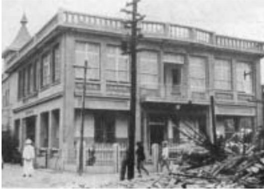
【照片 2-1-21】1935 年震災清水李宅磚構造未損壞
