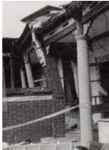
【照片 4-2-83】其中一根磚柱因為有二分之一的部分與圍牆緊密相接，造成磚柱在中間點的位置轉動角度過大而斷裂。
