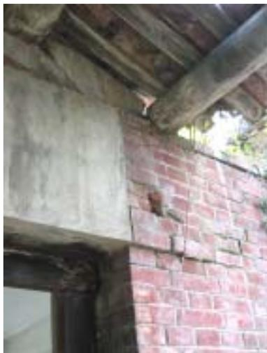
【照片 4-2-74】右過水的後簷水泥樑朝水平向的將壁體擠開破壞。
