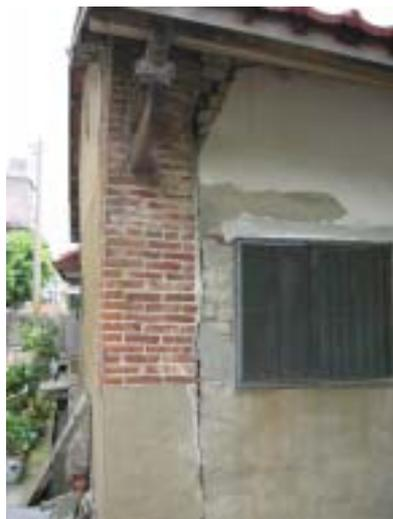
【照片 4-2-24】後檐牆與角落的磚柱間發生開裂與粉刷剝落
