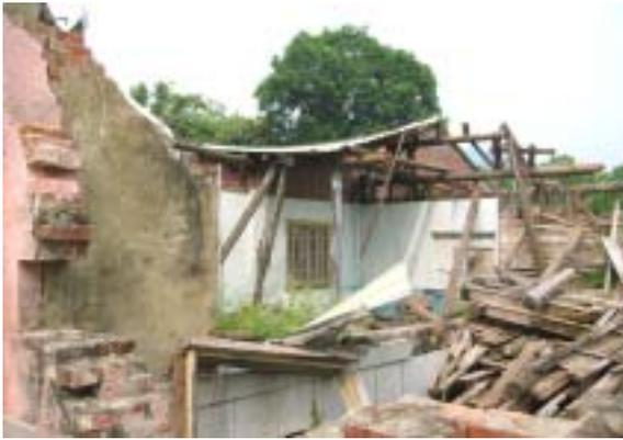
【照片 4-2-76】左右內外護龍及迴廊等建築體幾乎全面倒塌。
