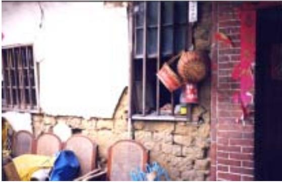
【照片 4-1-12】土角牆面破損，土角磚掉落
