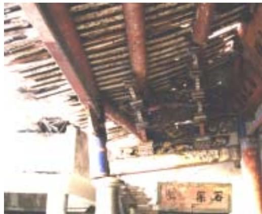
【照片 4-2-53】前簷柱木構架整體傾斜。
