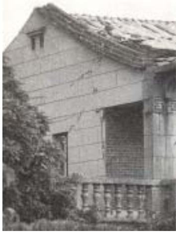
【照片 4-2-109】右側山牆沿開口部邊緣、山尖與木桁接合處產生開裂。
