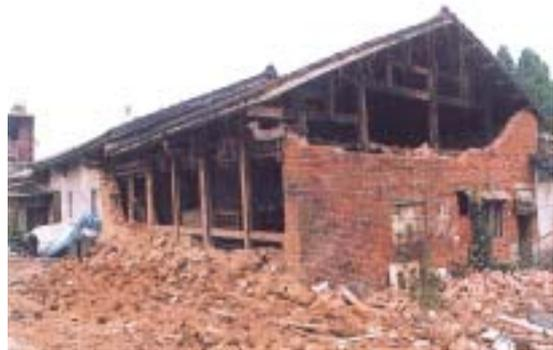
【照片 4-1-5】磚牆傾倒（南投魚池鄉顏宅）
