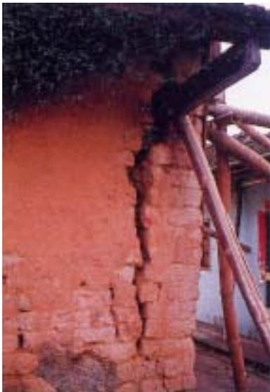
【照片 4-1-33】土角牆與木拱接合處壁體破裂（彰化田中央劉宅）
