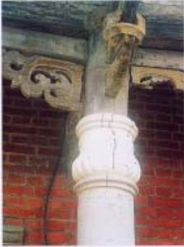
【照片 4-1-18】磚柱與木柱接合處破裂
