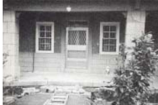
【照片 4-2-102】前簷廊簷柱傾斜，柱頭斷裂。
