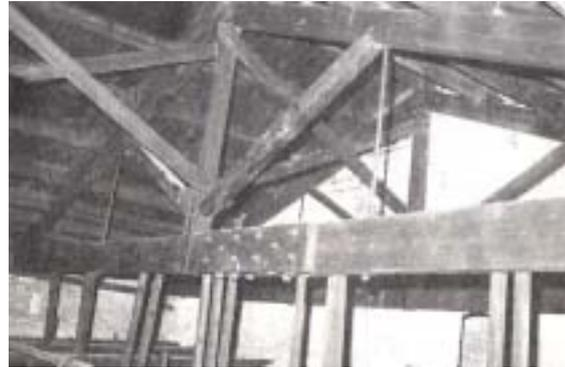
【照片 3-1-12】木桁架螺栓接於 RC 梁上
