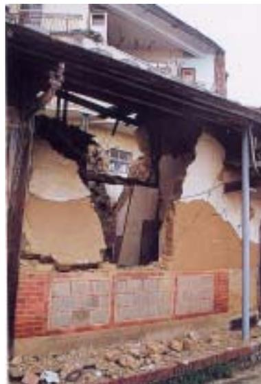
【照片 4-1-28】土角牆破裂傾倒（南投某宅）
