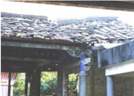
【照片 4-2-54】正廳屋脊斷折、屋面塌陷變形。
