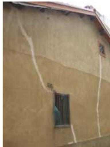
【照片 4-2-22】山牆面的裂縫由開口處延伸到屋頂及地面
