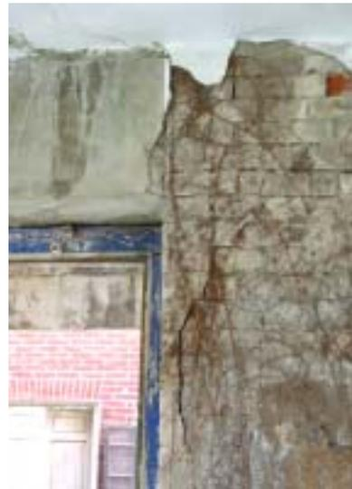
【照片 4-2-71】後簷水泥樑與磚牆相接的牆體發現裂縫產生。
