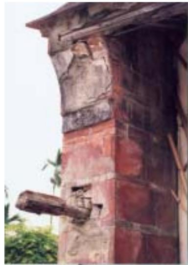
【照片 4-2-17】院牆已倒塌，山牆傾斜
