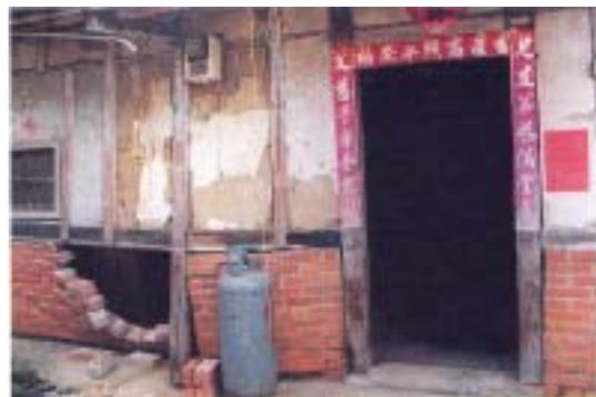
【照片 4-1-8】磚牆破裂傾倒(南投李宅)
