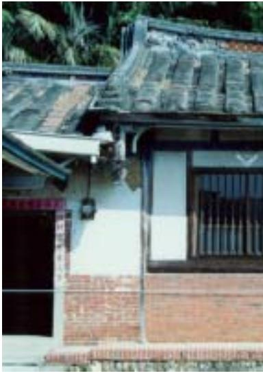
【照片 4-2-42】出檐處規帶開裂下傾
