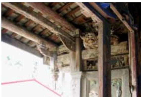
【照片 4-2-49】入口處木構件發生脫位傾斜。
