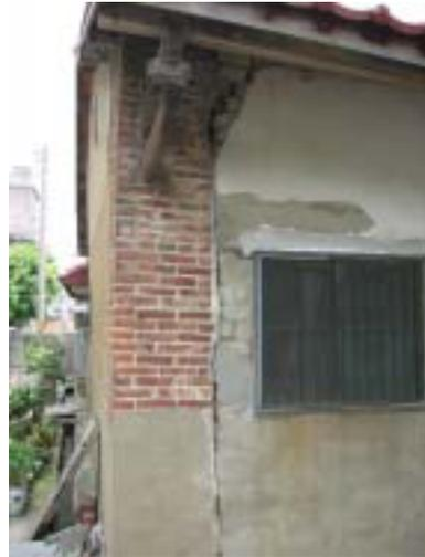
【照片 4-3-13】不同構造相推擠，弱者必然先受到破壞
