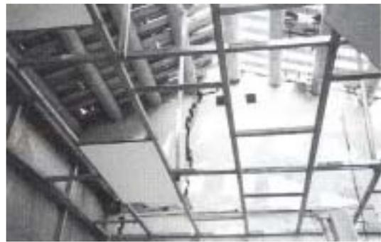
【照片 4-2-98】明間屋面受損，屋瓦掉落。承重牆壁體由與木桁接合處開始產生嚴重之開裂。
