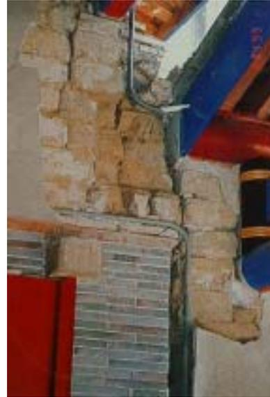
【照片 4-2-89】牆體脫開、粉刷剝落
