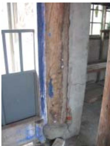
【照片 4-2-50】門邊的木柱與牆體分離並造成周圍牆體的擠壓破裂。
