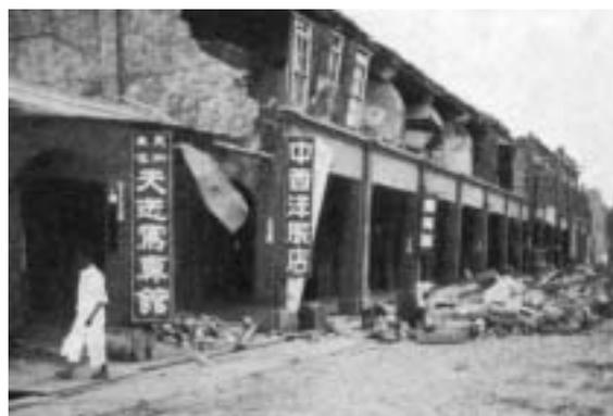
【照片 2-1-20】1935 年震災磚混土角構造損壞
