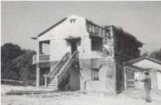
【照片 4-2-97】左次間木桁懸空，屋面陰坡完全掉落。
