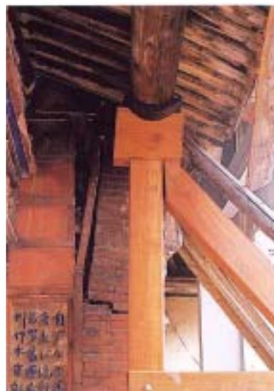
【照片 4-1-11】磚柱與斗砌牆脫開，磚柱斷裂傾斜（台中摘星山莊）
