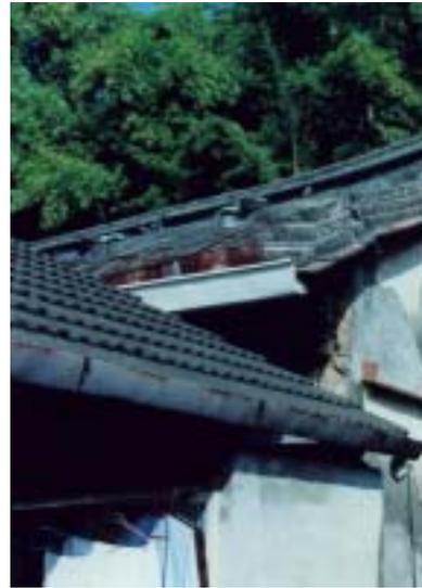
【照片 4-2-43】出檐處規帶開裂下傾
