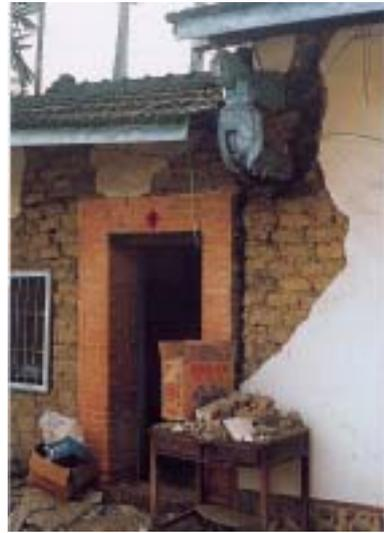
【照片 4-1-36】土角牆與磚造門框接合處脫開(南投林濁水古宅)
