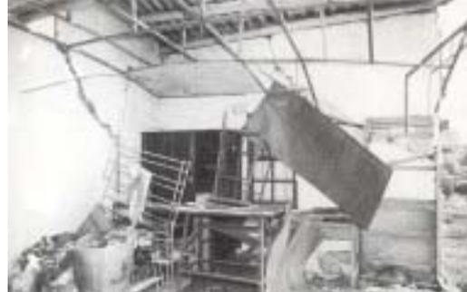
【照片 4-2-106】二樓後簷牆與木桁接合處牆體開裂。
