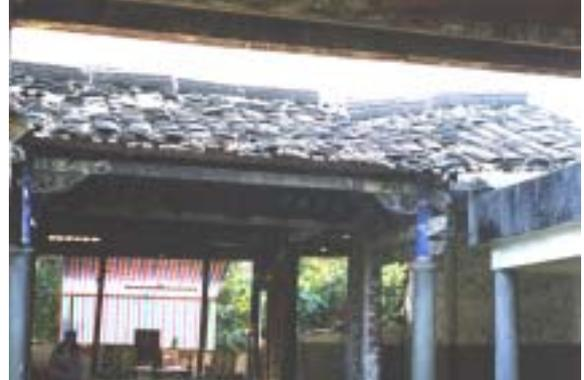
【照片 4-2-45】正廳屋脊的斷折、屋面屋瓦椽條鬆動掉落變形。
