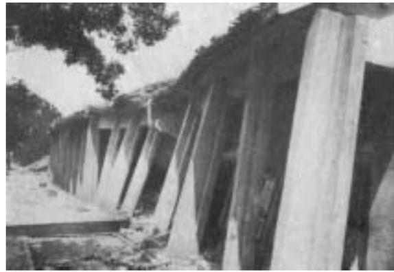
【照片 2-1-24】1935 震災內埔公學校 RC 構造損壞
