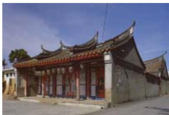
【照片 2-2-4】柱樑、承重牆混合構造
