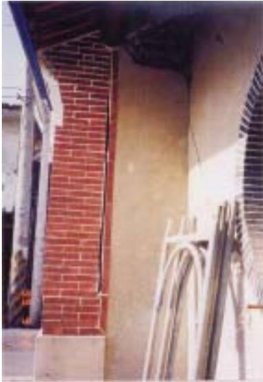
【照片 4-2-84】前殿右側磚柱脫裂
