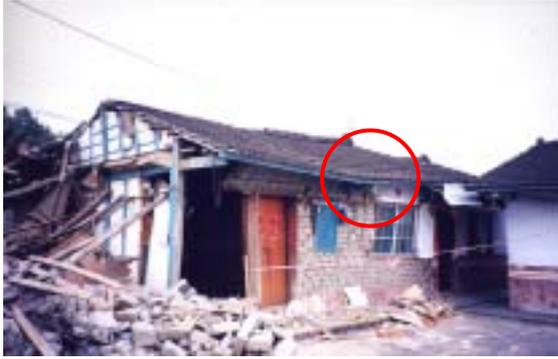
【照片 4-1-31】木拱下沉變形甚至脫落，導致建築屋面發生下沉變形
