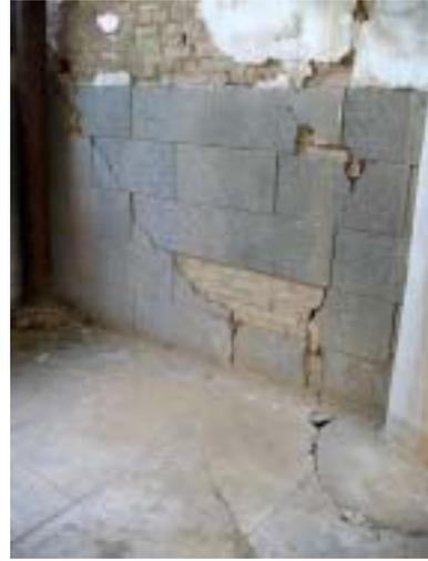
【照片 4-2-67】在柱基周圍的地坪有連續的裂縫產生，並一路蔓延至山牆面。
