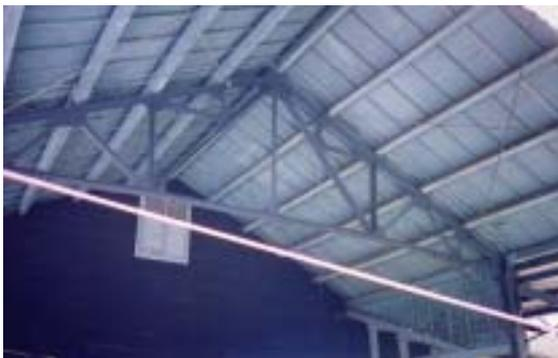
【照片 4-1-43】鋼屋架與木桁接合，無明顯之破壞發生
