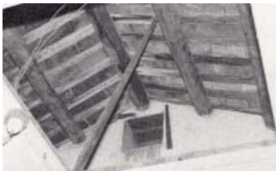
【照片 3-1-1】木桁直接埋置入牆體
