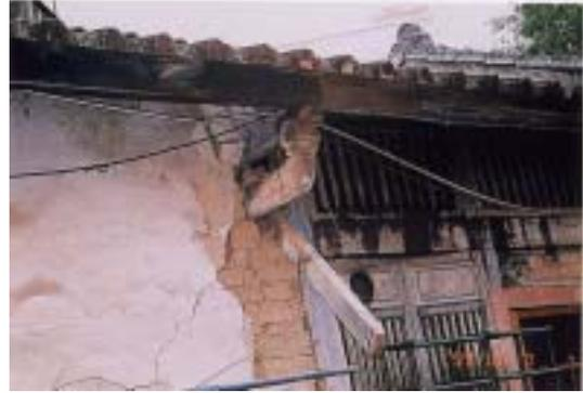
【照片 4-1-32】壁體出現裂痕，周圍土角磚破裂、掉落（台中林氏醉月樓）
