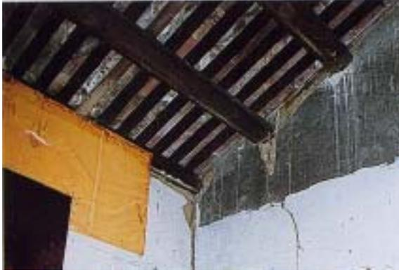
【照片 4-1-21】接合處發生不均勻沉降，壁體發生裂痕（台中廖氏武威堂）
