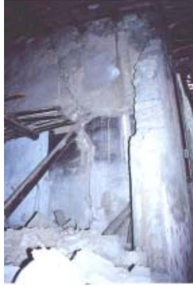
【照片 4-2-32】隔間牆產生數道由屋頂並經過閣樓木樑延伸下來的裂縫，甚至造成閣樓木樑插孔處脫位掉落。
