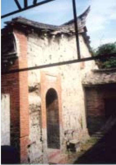
【照片 4-2-29】正身左側的山牆面，壁體粉刷層剝落十分嚴重，並使土角底材大面積的外露。
