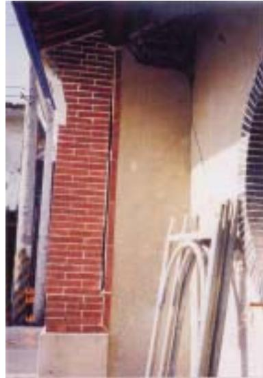
【照片 4-3-11】磚柱結構已受損
