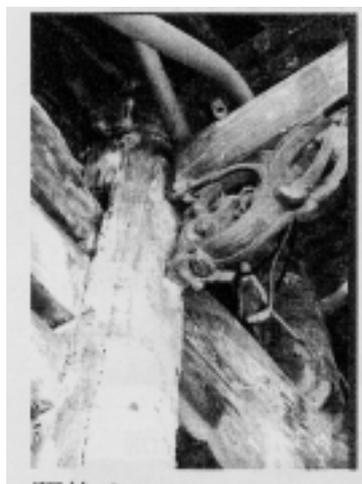
【照片 4-2-26】披麻捉灰部分已龜裂、剝落
