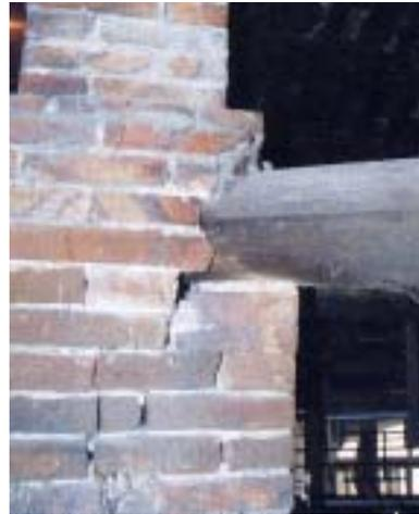
【照片 3-1-8】豎杆桁架與磚柱及壁體搭接
