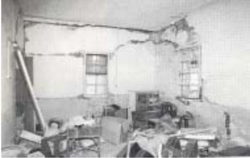
【照片 4-2-105】一樓左次間牆體嚴重龜裂，沿開口部邊緣 45 度開裂。
