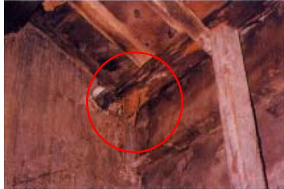
【照片 4-1-22】木桁接合處腐朽，脫離土角牆體（彰化下黎林宅）
