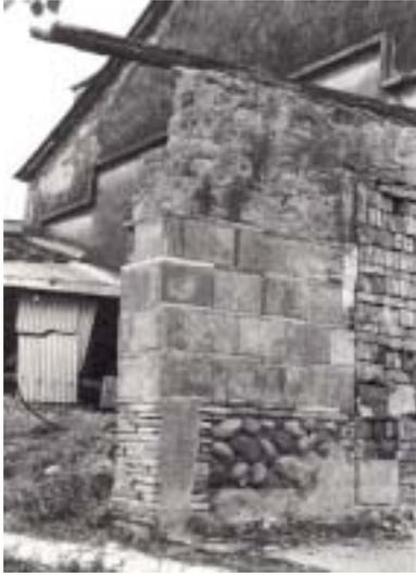
【照片 3-1-13】土角磚牆混砌斗子磚、卵石牆基
