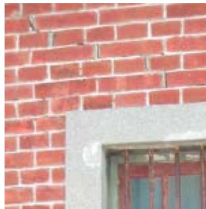
【照片 4-2-6】後簷牆的窗口產生沿破縫向屋頂蔓延的
