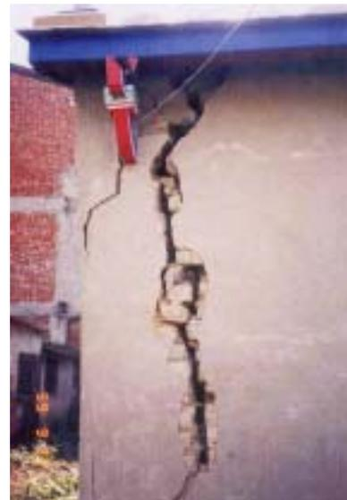
【照片 4-2-91】左後牆角垂直開裂，軟挑處也出現裂紋
