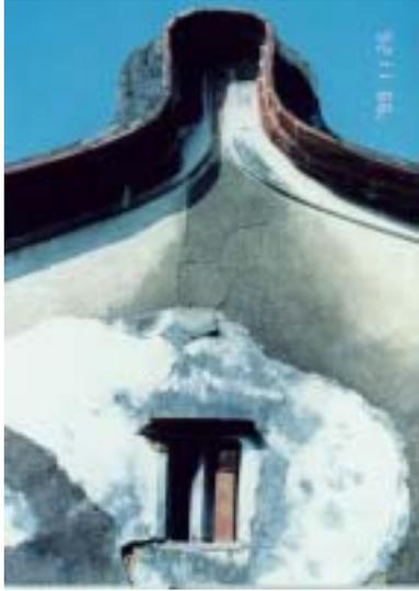
【照片 4-2-39】山牆面許多粉刷層剝落
