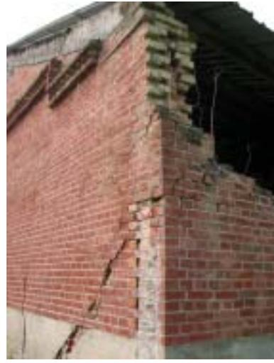
【照片 4-2-63】牆角的斜向開裂深達牆體的另一面。
