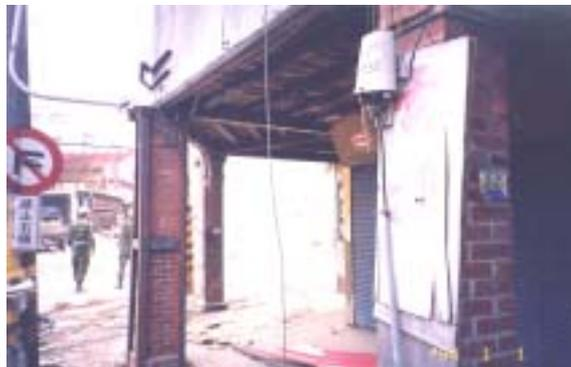
【照片 4-3-21】磚柱移位，以鋼構材固定
