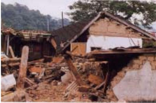
【照片 4-1-23】木桁脫離牆體，導致屋頂塌落（台中新伯宮校書第）
