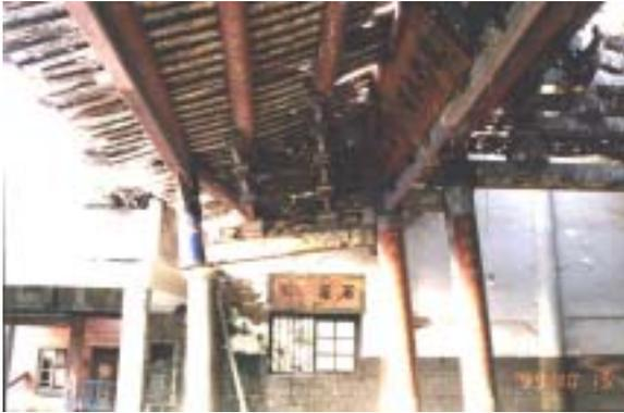
【照片 4-2-44】正廳等建築體的構架傾斜、構件的脫榫或掉落。
