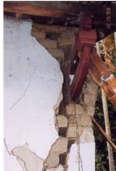
【照片 4-1-34】土角牆與木拱接合處壁體破裂（南投江宅）
