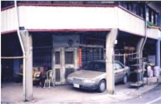
【照片 4-1-41】RC 柱與木樑接合，無破壞之情形產生
