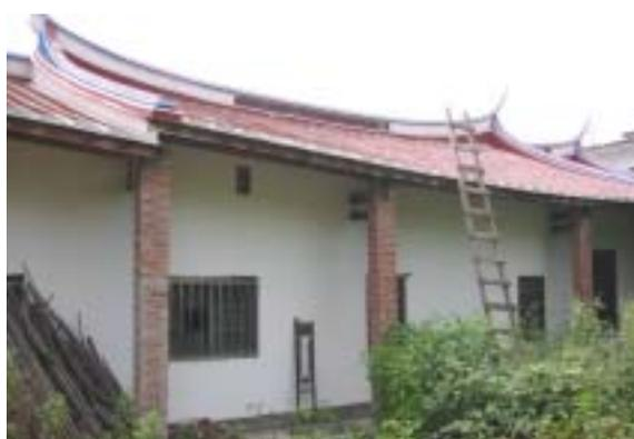
【照片 4-2-38】屋主現已將後簷原磚柱列修補復原。
