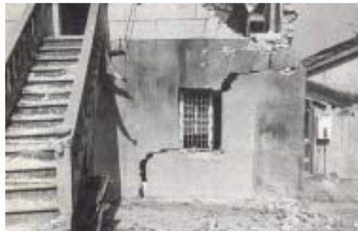
【照片 4-2-108】左側山牆受剪力破壞，沿開口部邊緣開裂，並延伸至後簷牆。
