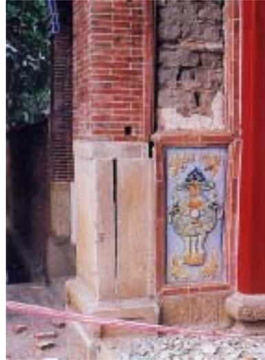
【照片 4-1-19】磚柱位移，石台基破裂
