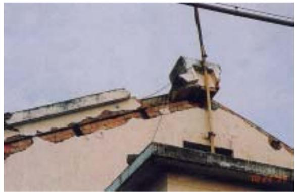
【照片 4-2-93】山牆頂端處發生脫位並出現外推位移的情形。
