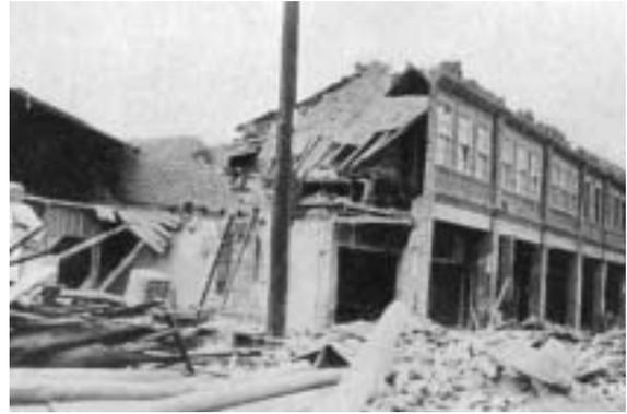
【照片 2-1-22】1935 年震災二樓半磚構造損壞
