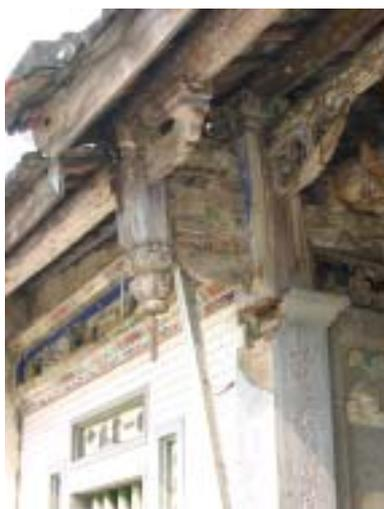
【照片 4-2-48】入口處木構件發生脫位傾斜。
