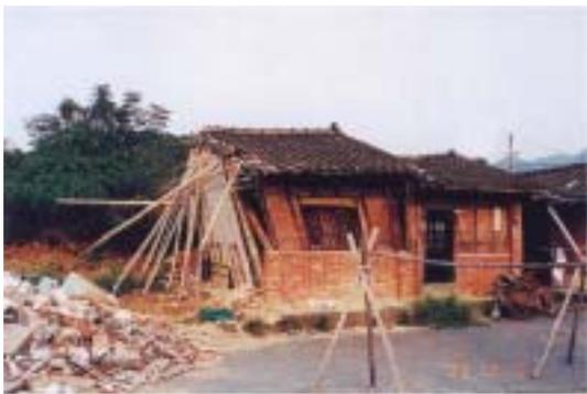
【照片 4-1-7】穿斗式編竹夾泥牆傾斜
