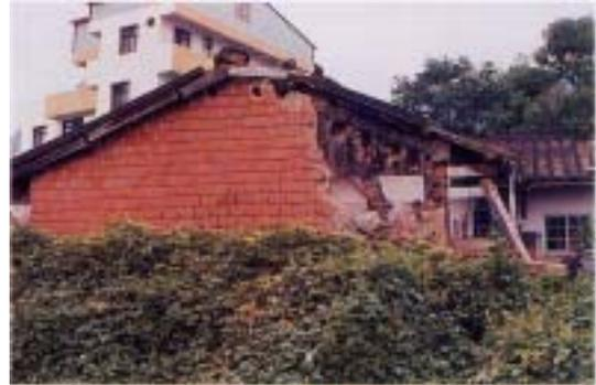
【照片 4-1-24】從與木桁接合點處產生壁體破裂，導致土角牆坍塌（台中許宅）
