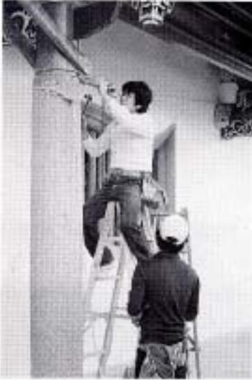
【照片 3-1-9】木短柱與 RC 柱樑接
