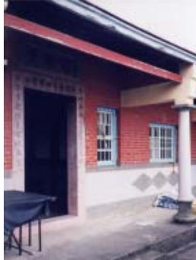
【照片 4-1-42】RC 柱樑與磚牆接合
