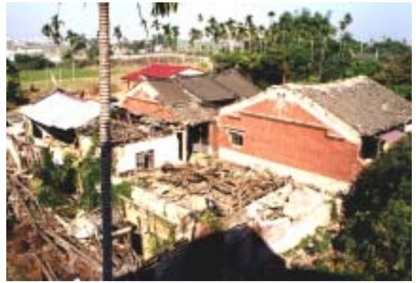
【照片 4-2-77】左右內外護龍及迴廊等建築體幾乎全面倒塌。
