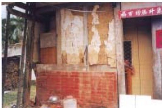
【照片 4-1-9】編竹夾泥牆壁體產生變形
