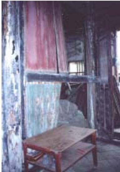
【照片 4-2-33】由於屋桁的木構建腐朽斷裂，與神明廳之隔斷檯板因擠壓而變形。
