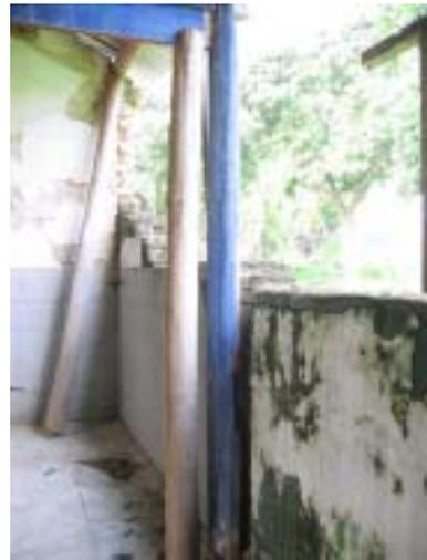
【照片 4-2-65】，後簷牆體斷面上半部已倒塌，下半部牆體則依然保持完整。
