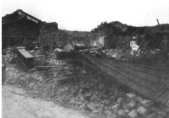
【照片 2-1-19】1935 年震災梧棲土角造構造崩塌
