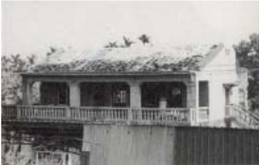
【照片 4-2-99】屋面陽坡規帶龜裂，脊頭崩落。
