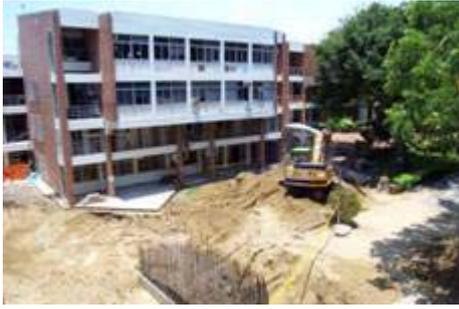
圖 3-17 成功大學建築系景觀化人工濕地處理校園污水與生態入滲池施作情況，施工歷時四個月，民國九十二年七月到十月底完工。
