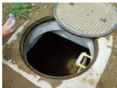
圖 2-44 地下貯水槽孔
