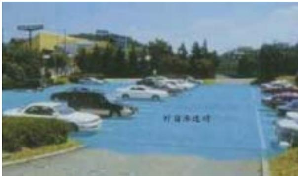
圖 2-19 利用透水面來自然滲透，自然滲透無法迅速滲透時於貯集（約車門下緣高度左右）、且設置雨水的溢流設施，以確保停車場車輛的安全。
