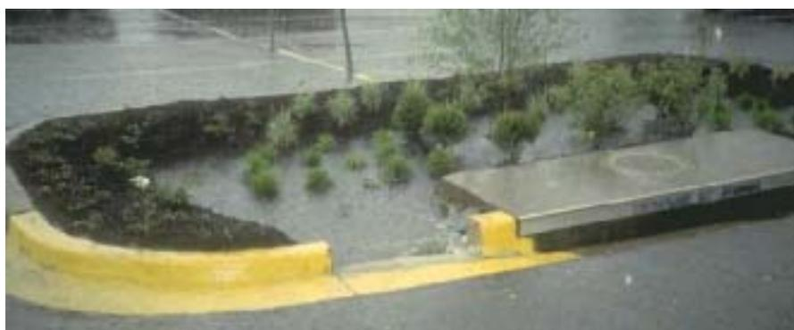
圖 2-26 停車場分隔島小型貯集滲透，可以短暫蓄留雨水
