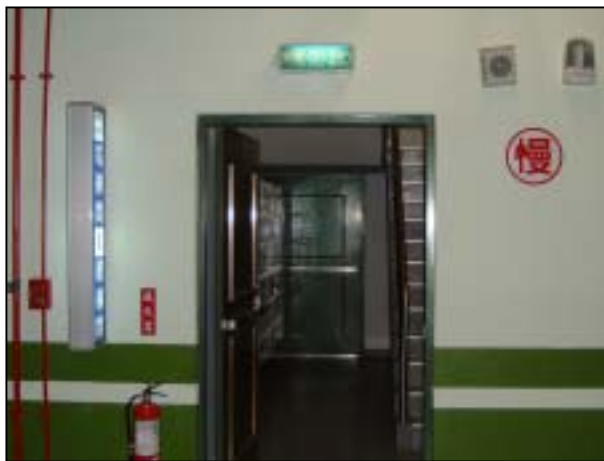
圖 3.12 高層建築訪視照片 - 安全樓梯間未堆置雜物（新光運河大樓）
