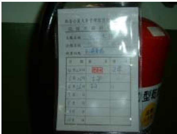
圖 3.13 高層建築訪視照片 - 落實檢查管理機制（新光運河大樓）
