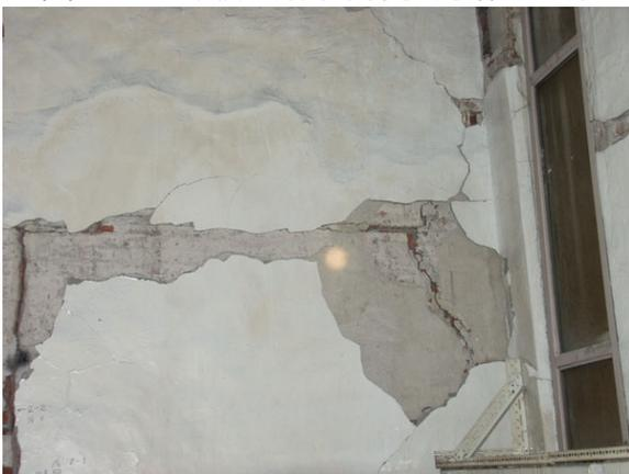
圖 4-1.3 地震造成灰作牆面的破壞
