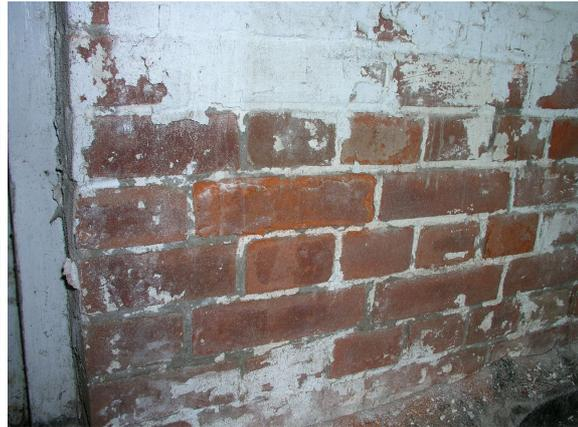
圖 4-1.2 室內牆面灰作裝修層剝落
