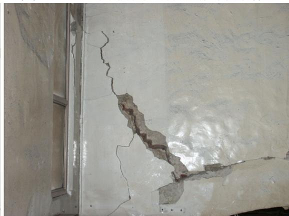
圖 4-1.4 地震造成灰作牆面的破壞
