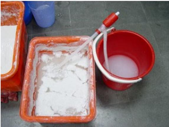
圖 3-1.20 除去養灰槽之隔離水
