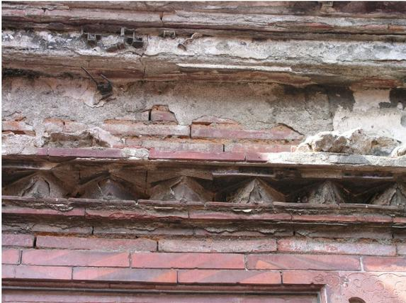
圖 4-1.1 外牆灰作因漏水剝落、風化
