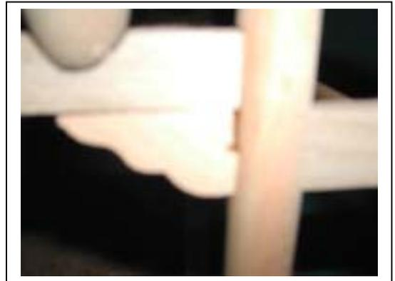
圖 5-7 疊斗式木構架模型托木細部
