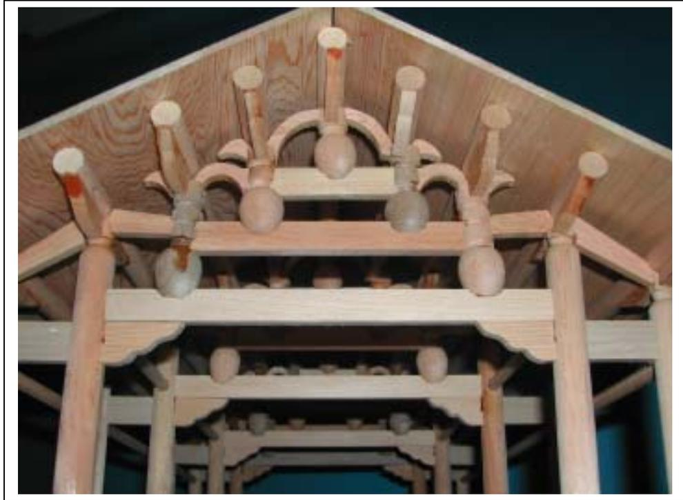
圖 5-5 疊斗式木構架有覆蓋屋頂模型棟架細部
