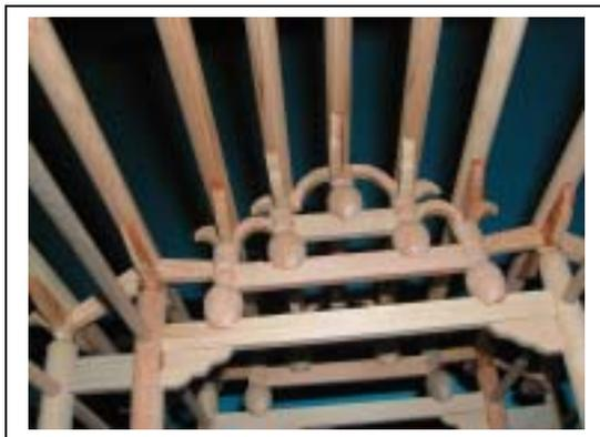
圖 5-6 疊斗式木構架模型內部棟架細部
