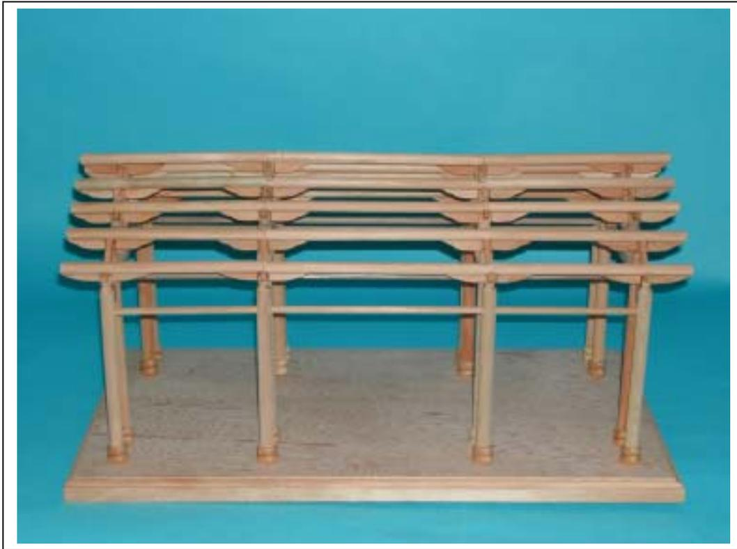
圖 5-1 疊斗式木構架模型側面
