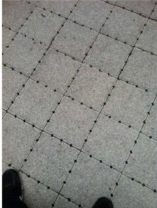
圖 4-9 國立臺北科技大學新生側門孔洞邊透水磚
