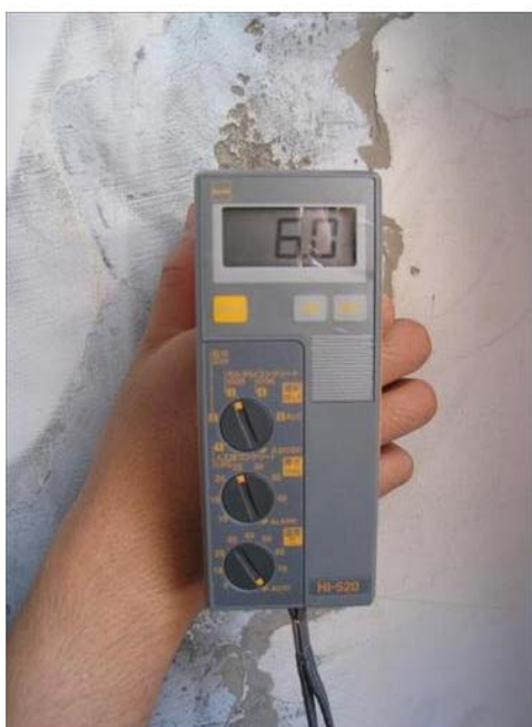
圖 4-31 牆壁含水率正常 日本 KETT HI-520 溼度計
