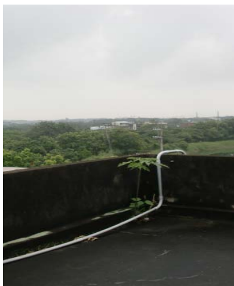
圖 4-3 連木瓜樹都會長在 屋頂上不漏水才怪 資料來源：本研究拍攝
