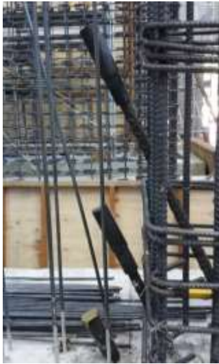
(a) 埋入基礎部分等待續接
