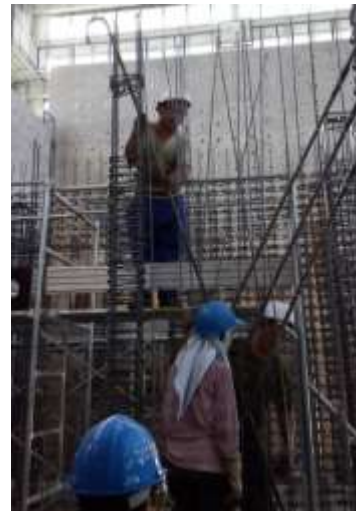
(d) 對角向鋼筋搭配邊界構材組裝
