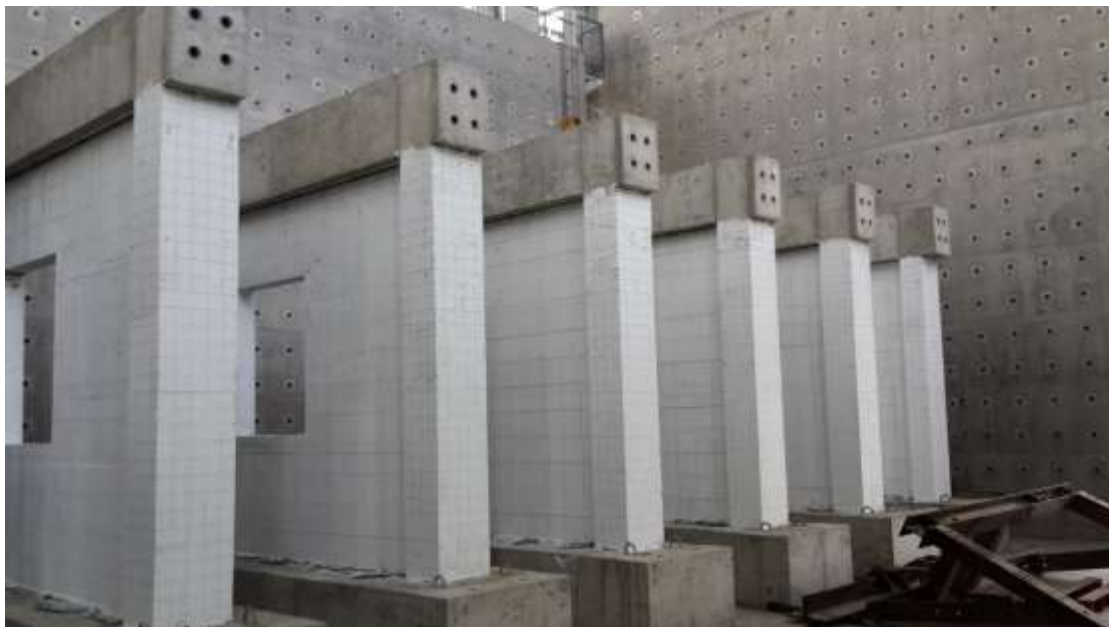
圖 3-60 試體拆除模板(油漆完成)
