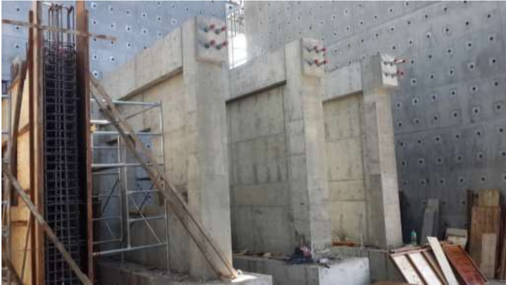
圖 3-59 試體拆除模板
