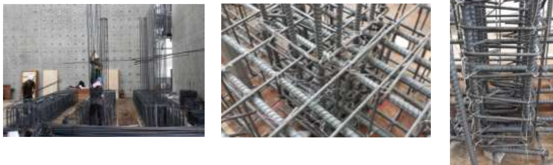
圖 3- 46 柱主筋及閉合箍筋埋入基礎
