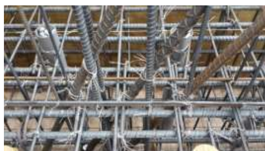
圖 3- 48 對角向鋼筋埋入基礎
