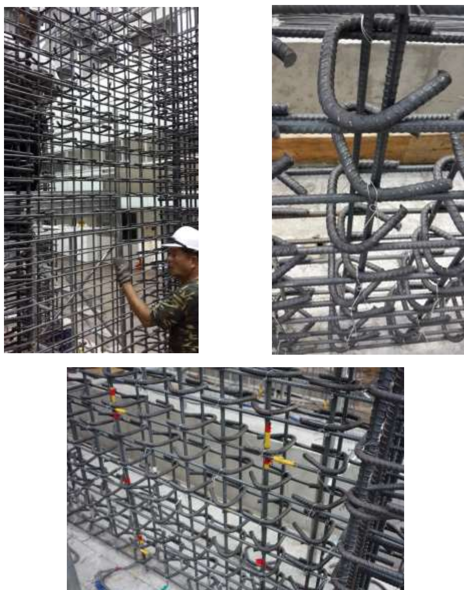
圖 3-9 密集配置鋼筋及每交點彎鉤繫筋 資料來源:本研究拍攝
