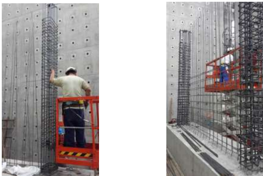
圖 3- 52 試體基礎拆模後，綁紮其上柱箍筋及牆水平筋
