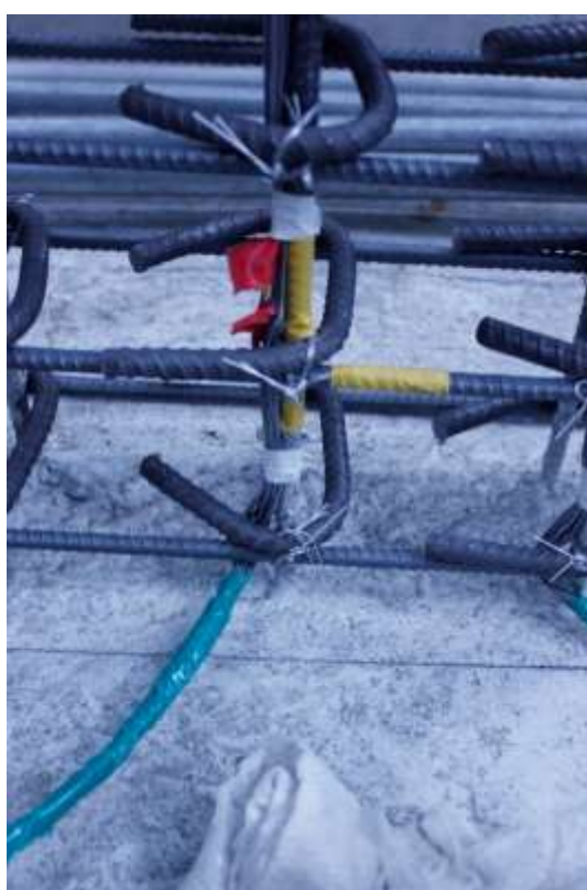
圖 3-29 應變計線由牆底部順出待接
