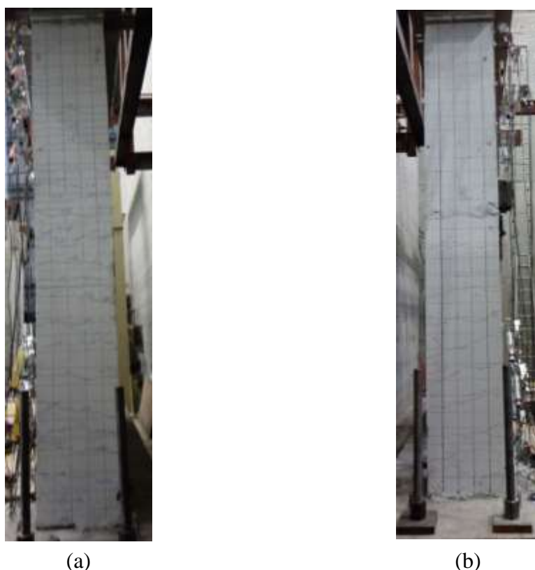
圖 4- 79 試體六在+0.5% drift 下裂縫情況(a)右柱面(b)左柱面 (資料來源：本研究拍攝)
