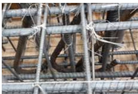
圖 3- 48 對角向鋼筋埋入基礎
