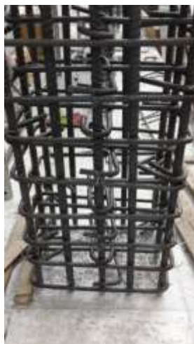
(d)柱鋼筋籠
