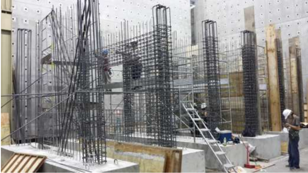
(a) 試體四至六綁紮基礎上部鋼筋，試體一至三陸續封牆、柱模板
