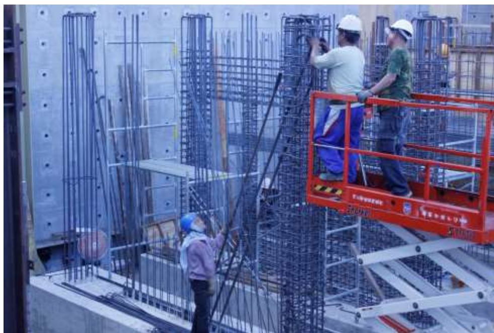
圖 3- 38 左下-右上斜對角向鋼筋上肢由柱外側插入，微調發展長度及角度 資料來源:本研究拍攝
