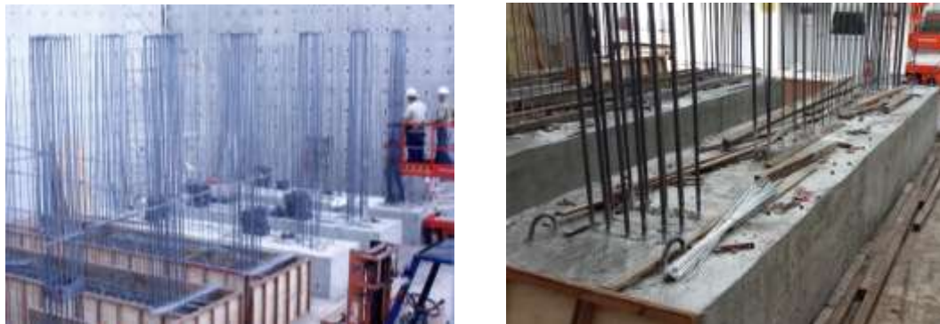
圖 3- 51 試體一至三基礎拆模
