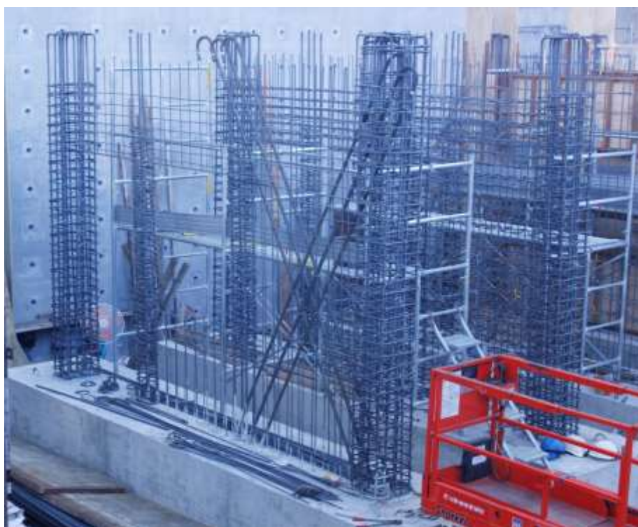
(g)對角向鋼筋組裝完成
