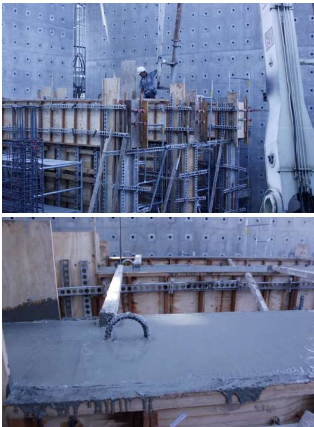
圖 3- 58 試體澆置牆、柱及加載頂梁
