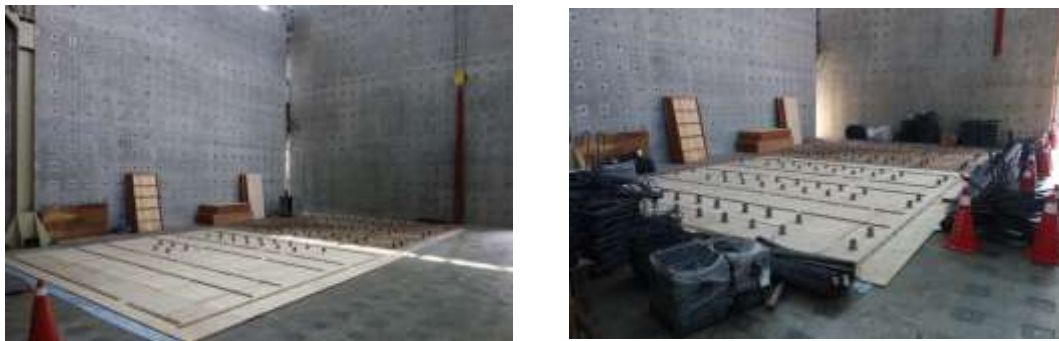
圖 3-44 試體放樣及鋼筋進場
