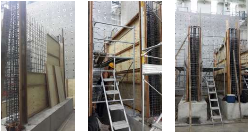
圖 3- 56 試體牆、柱封模
