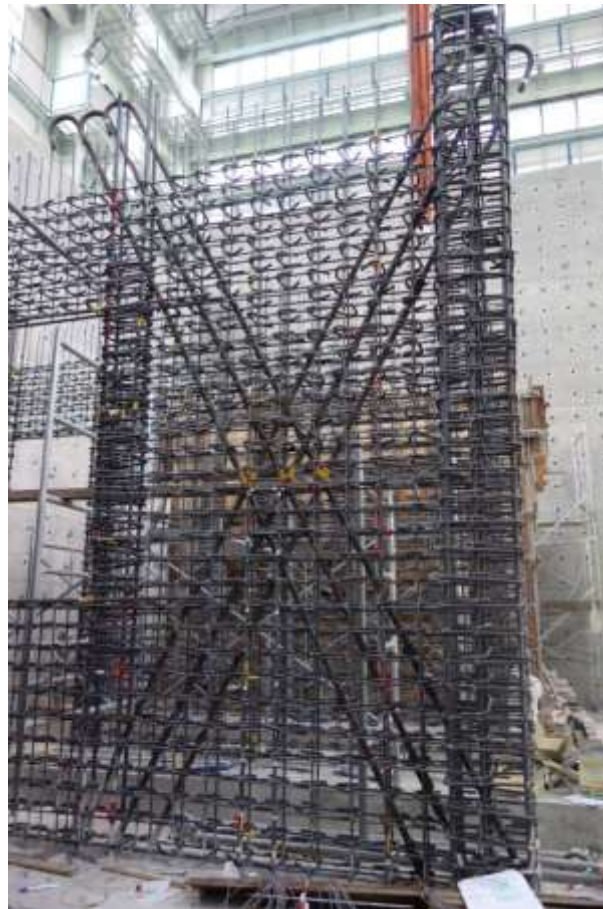
圖 3- 11 對角向壓力鋼筋
