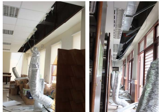
圖 2-26 空調風管掉落情況 (資料來源：國家地震工程研究中心勘災團隊，2013)
