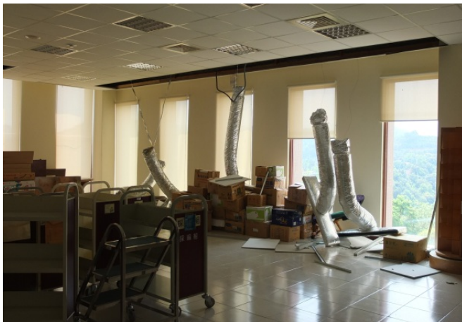
圖 2-26 空調風管掉落情況 (資料來源：國家地震工程研究中心勘災團隊，2013)
