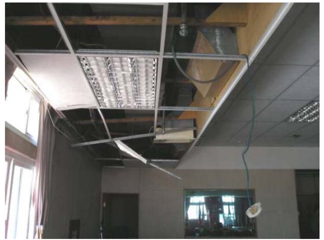
圖 2-7 沿結構牆面之輕鋼架天花板掉落 (資料來源：宋裕祺等，2010)
