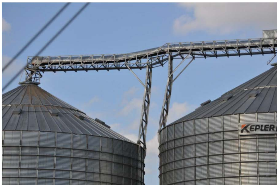
圖 2-42 輸送帶變形損壞 (資料來源：ATC, 2011)
