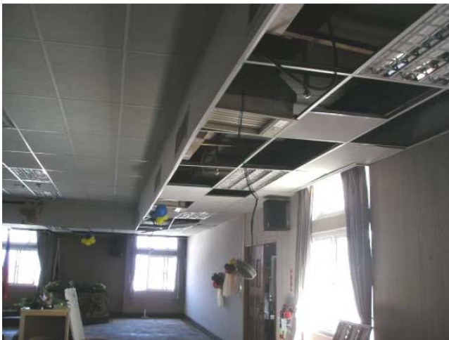
圖 2-7 沿結構牆面之輕鋼架天花板掉落 (資料來源：宋裕祺等，2010)
