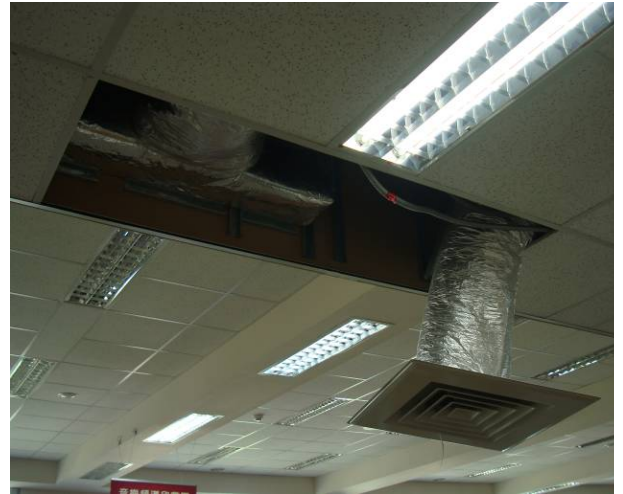
圖 2-25 天花板掉落之出風口 (資料來源：國家地震工程研究中心勘災 團隊，2013)
