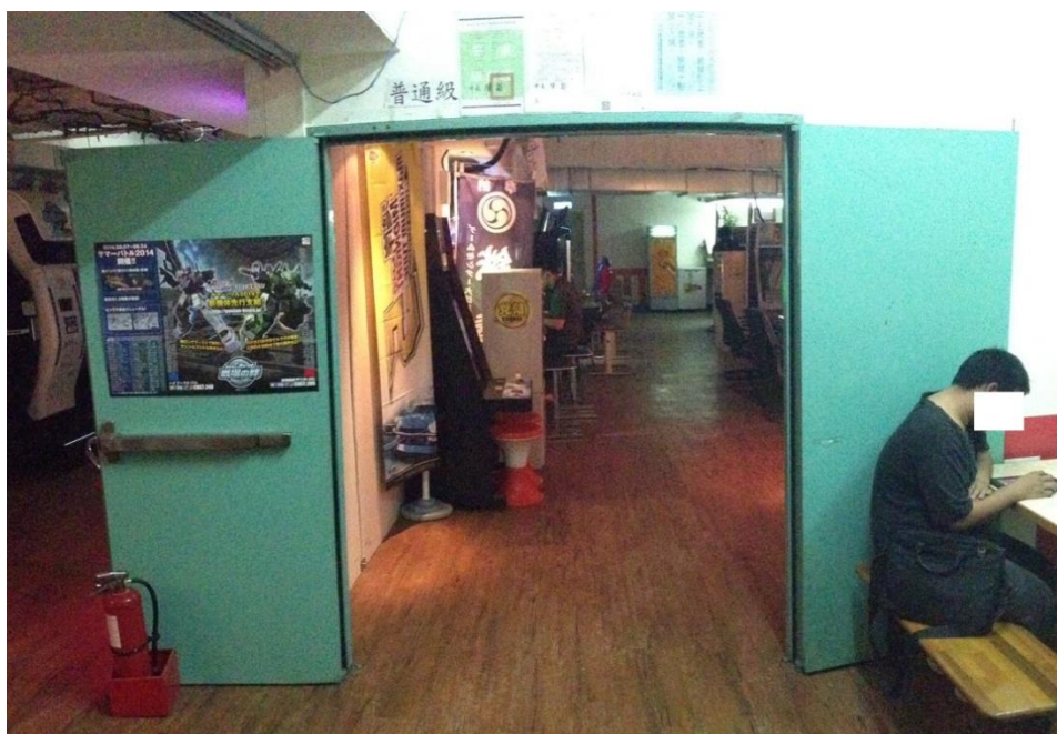
圖 2-3 某娛樂場所常時關閉式防火門設置情形
