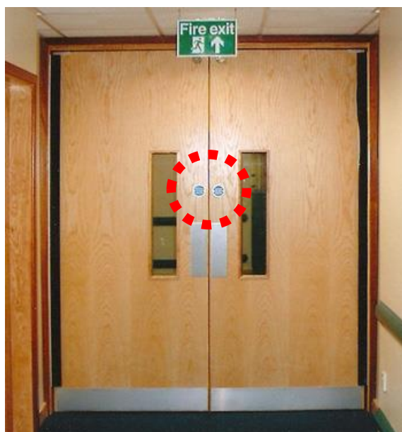
圖 3-4 防火門標示之張貼位置（虛線圈選處）
