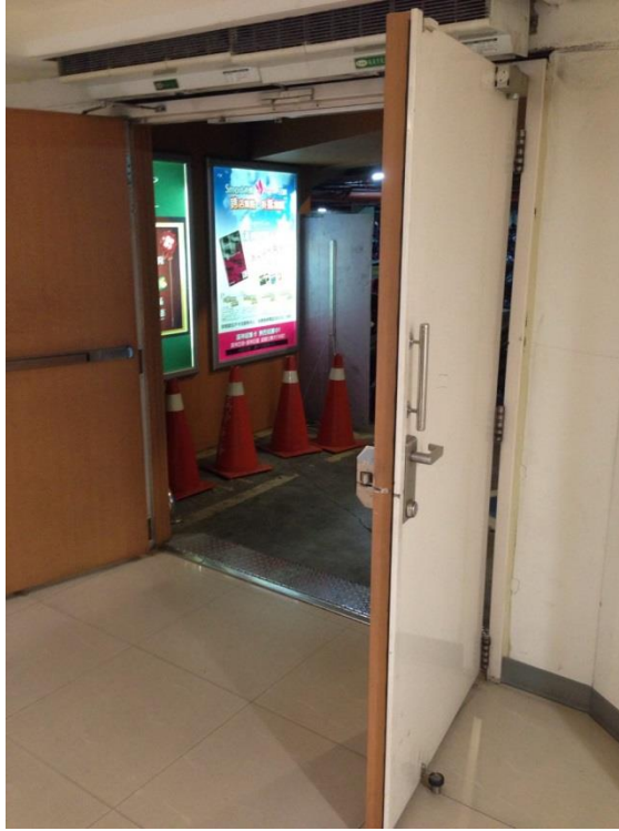
圖 2-5 某商場百貨常時關閉式防火門設置情形 (資料來源：本研究自行拍攝)
