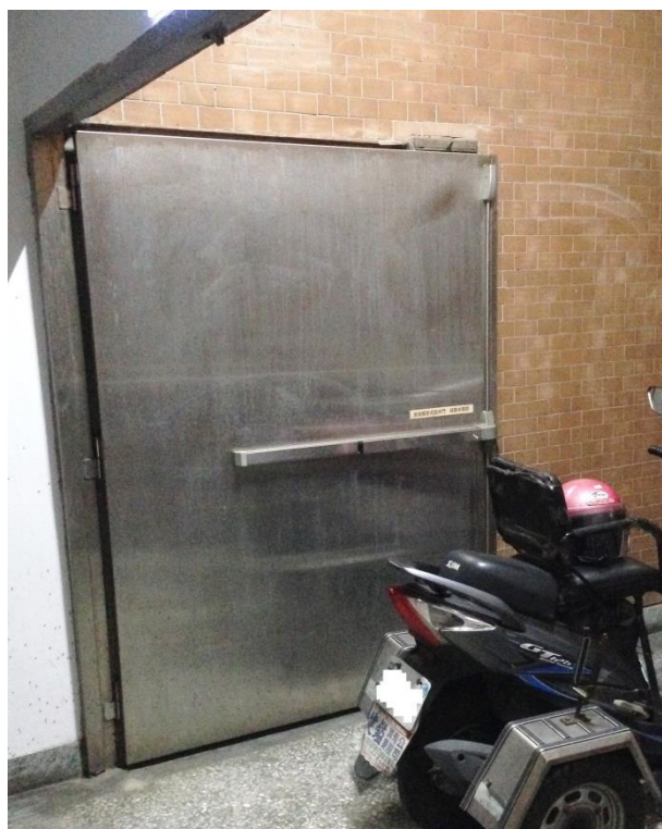
圖 2-8 某辦公場所常時關閉式防火門設置情形
