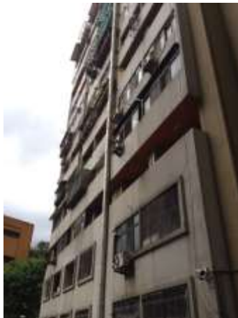
圖 2-48 中正國宅外牆明管拉設 (圖片來源：本研究拍攝)
