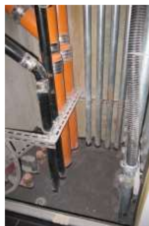
圖 2-55 昇陽麗石管道間（小坪數） (圖片來源：本研究拍攝)
