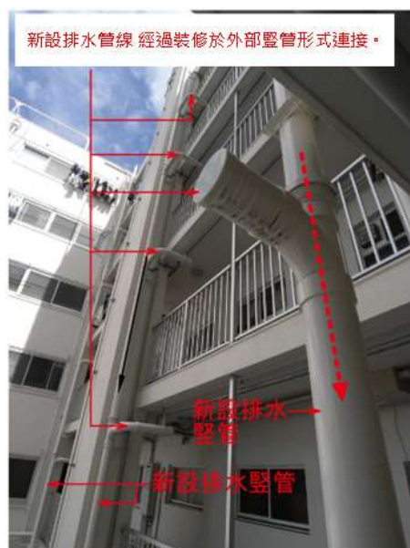
圖 2-20 新設管線說明 (三) (圖片來源：信濃設計研究所)
