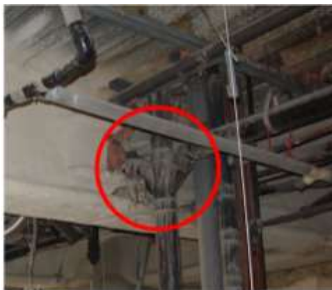
圖 3-3 雙斜 T 型排水接頭（一）
