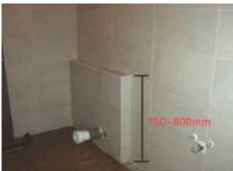
圖 3-7 座式馬桶糞管牆排（一） （圖片來源：龍昇室內設計工作室）
