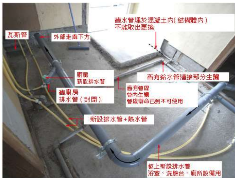
圖 2-17 新設配管施工過程（二） （圖片來源：信濃設計研究所）
