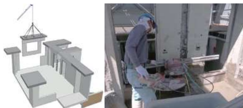
圖 2-28 梁與壁解體卸載
