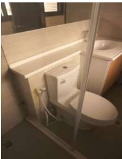
圖 3-8 座式馬桶糞管牆排（二） （圖片來源：本研究拍攝）
