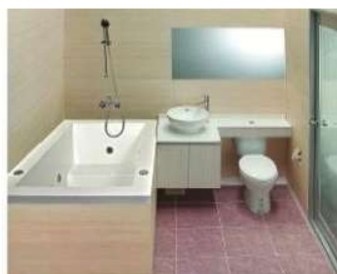
Step 8 整體衛浴安裝完成
