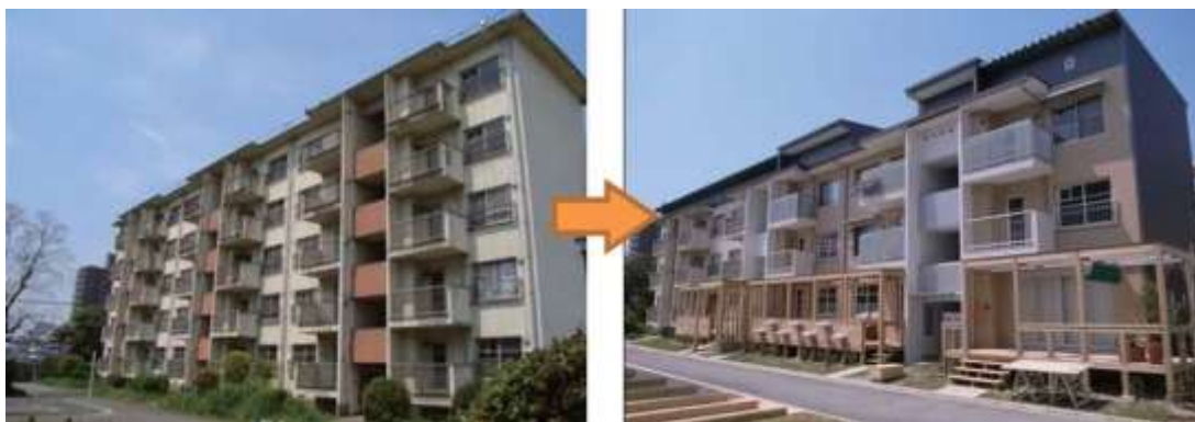
圖 2-40 向ヶ丘第一団地 28 號棟南側（修改前與修改後） （圖片來源：UR 都市機構）
