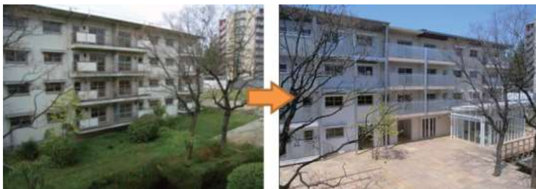
圖 2-39 向ヶ丘第一団地 27 號棟南側（修改前與修改後） （圖片來源：UR 都市機構）
