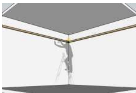
Step3 按照墨線於天花板四周釘水平邊材
