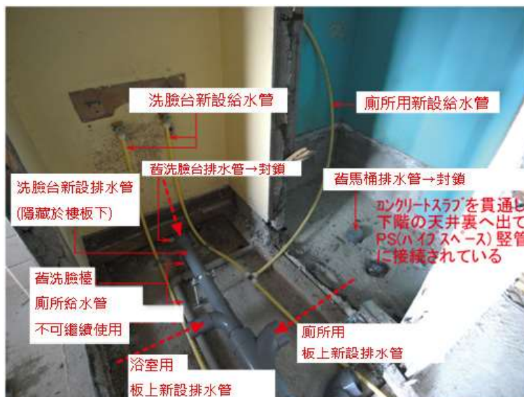
圖 2-16 新設配管施工過程（一） （圖片來源：信濃設計研究所）
