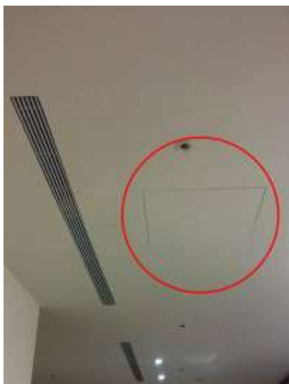
圖 3-20 暗架天花板檢修孔 (圖片來源：本研究拍攝)
