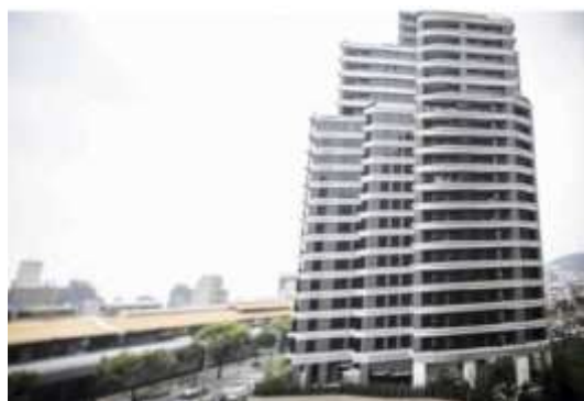
圖 2-51 昇陽麗石外觀 (圖片來源：昇陽建設)
