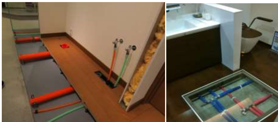
圖 3-19 高架地板實際案例 (圖片來源：本研究拍攝)
