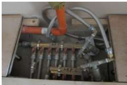
圖 4-13 開放建築管線接頭集中設置
