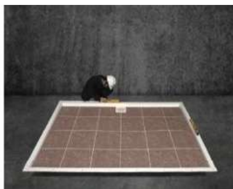
Step 2 底盤水平調整確認
