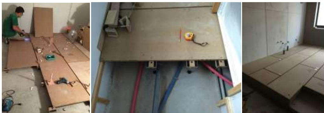
圖 3-17 高架地板實際施工照片
