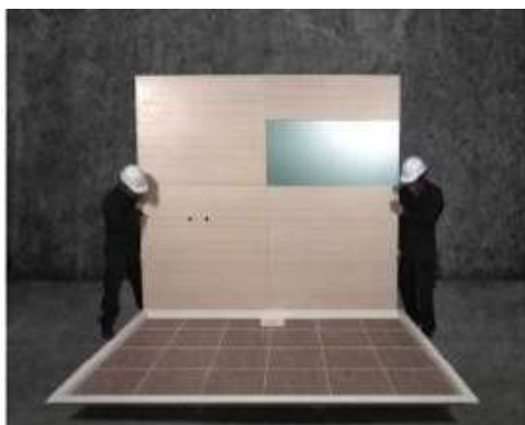
Step 3 安裝隔間牆板之一
