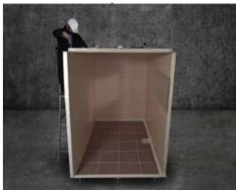
Step 5 安裝天花板
