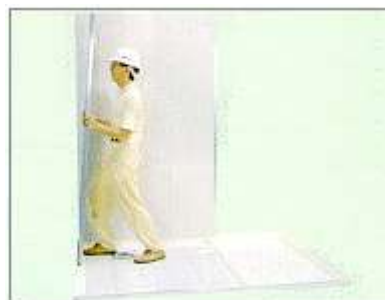
Step 2 壁板組裝架設
