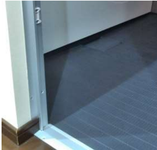
圖 3-12 整體衛浴安裝穩固確認 (圖片來源：本研究拍攝)
