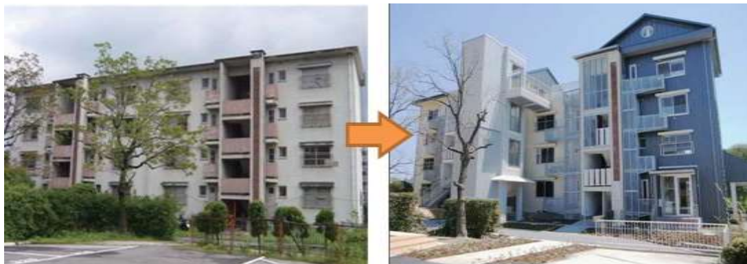
圖 2-38 向ヶ丘第一団地 26 號棟北側（修改前與修改後） （圖片來源：UR 都市機構）
