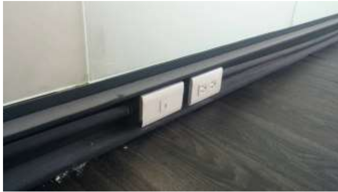
圖 3-16 戶內管線牆前配管 (圖片來源：本研究拍攝)
