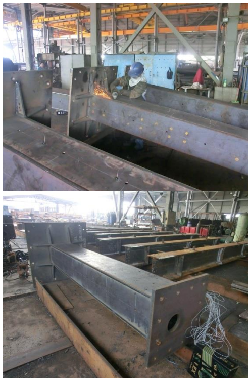
圖 3-10 箱型鋼柱組立完成
