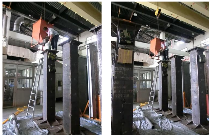
圖 3-13 箱型鋼柱之混凝土澆置
