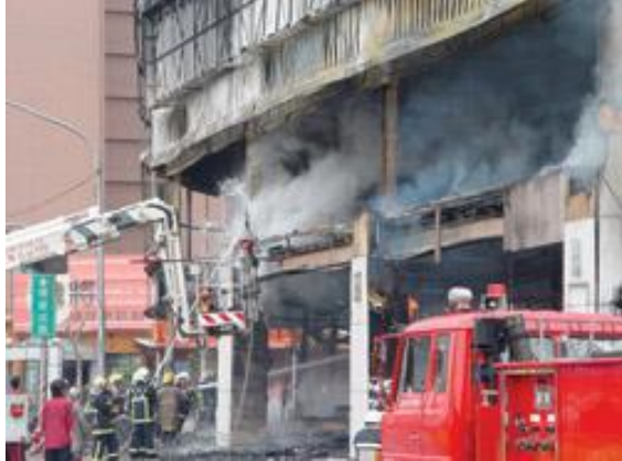
火災發生時消防人員搶救之情形
