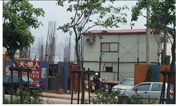
工地臨時事務所
