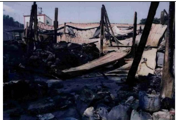
倉庫 1 內部物品靠近北側西端處受燒情形
