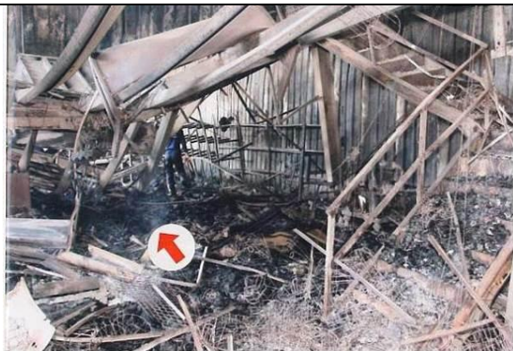
137-4 號北側 1 樓內部火災後情形
