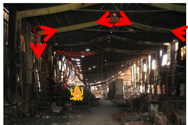
(4)鋼梁接頭受熱後產生強大拉力
