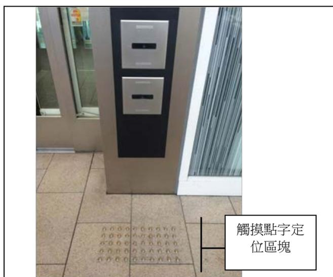
圖 3-10 羽田機場電梯語音系統與觸摸點字定位區塊
