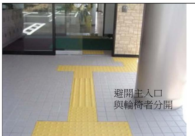
圖 3-24 入口導盲磚設置
