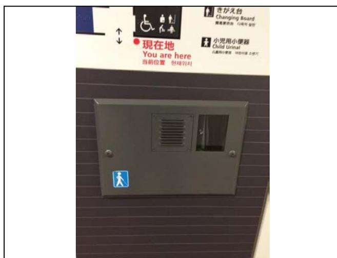
圖 3-8 羽田機場廁所外側說明板的點字與語音導引系統
