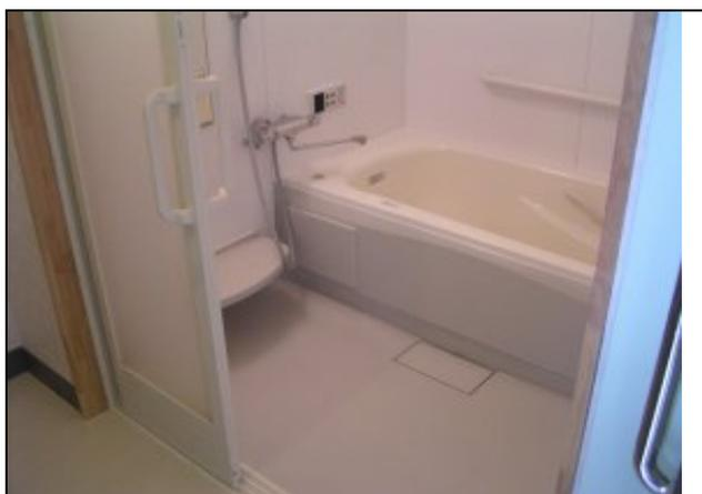
圖 3-25 配合輪椅使用的浴室寬廣入口設計
