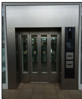
**圖 4-4 羽田機場電梯入口寬幅可供輪椅進出**
