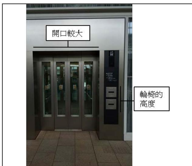
圖 3-9 羽田機場無障礙電梯外觀與右側的語音導引系統
