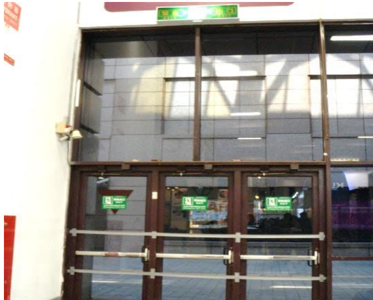
圖 3-23 避難出入口管制-膠帶封上
