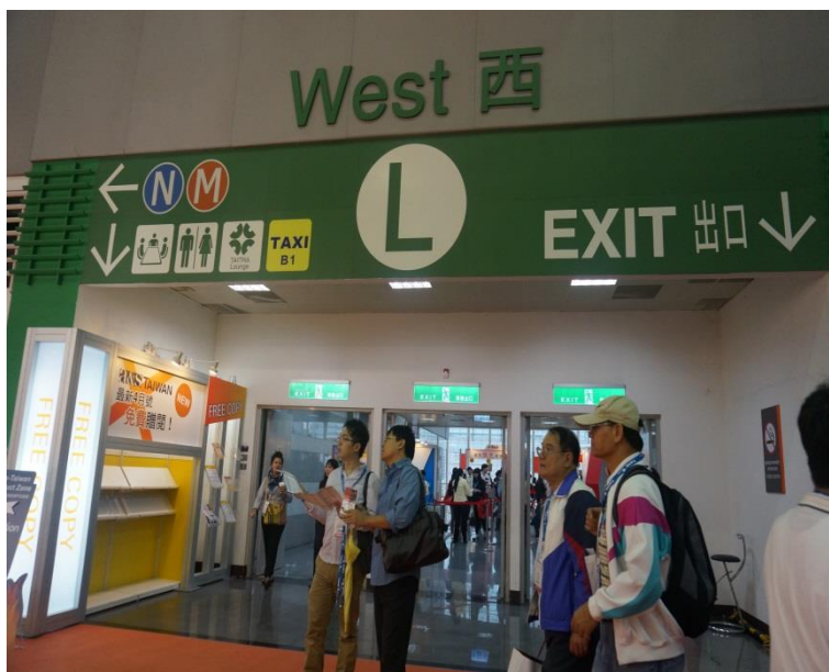
圖 3-71 牆面上出口標示及出口標示燈
