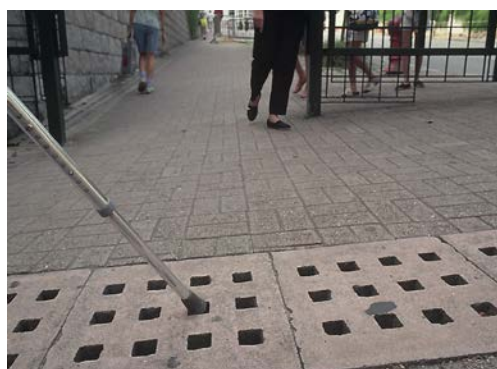
圖 3-2-5 格柵開口過大影響使用 圖 3-2-6 格柵開口方向影響行進
