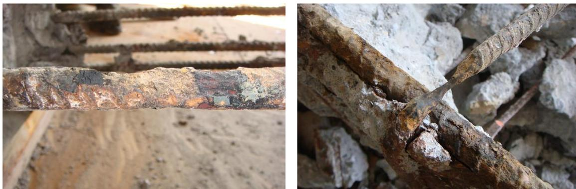
圖 2 - 12 主筋與箍筋腐蝕情形
