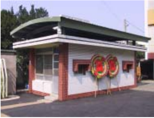
「圖4」平屋頂加彩色鋼板的雙層屋頂隔熱法
