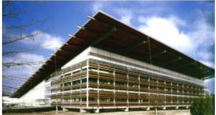
「圖5」以雙層隔熱屋頂為造型的法國波爾多航管中心
