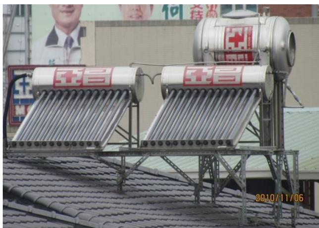
圖 1-1 安裝於屋頂之太能熱水系統及水塔
