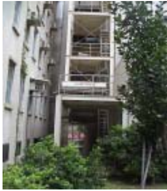
間接排水井和集水塔
