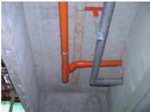
■ 明管系統的給水管和排水橫管
