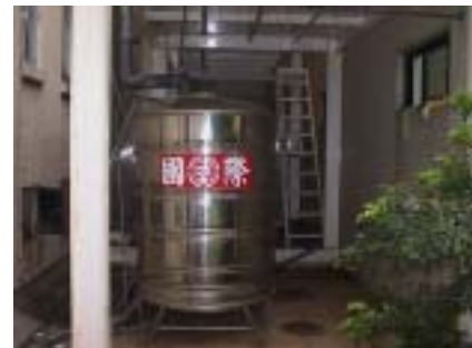
位於間接集水井下的集水塔
