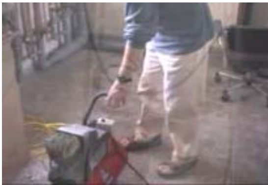
利用空氣壓縮機將管內空氣壓力加壓
