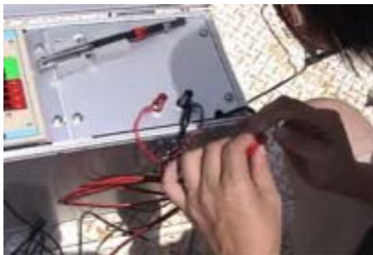
13F 安裝熱線風速計接線
