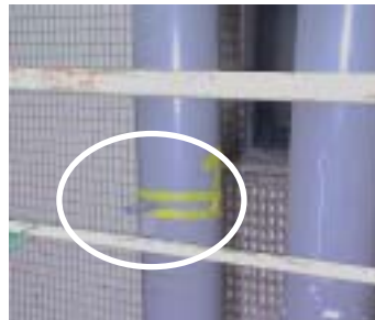
熱線風速計安裝位置
