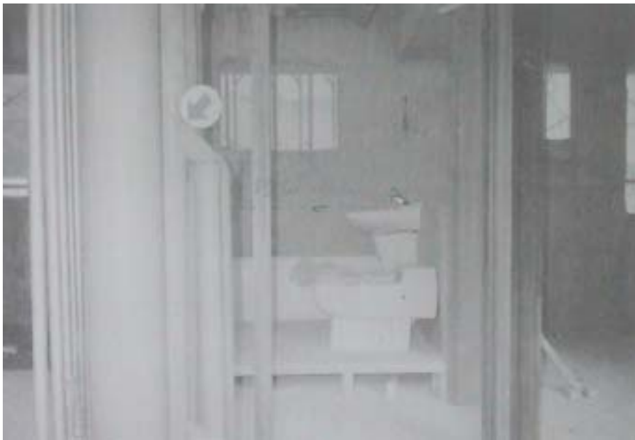
■ 器具通氣管接入立管位置。
