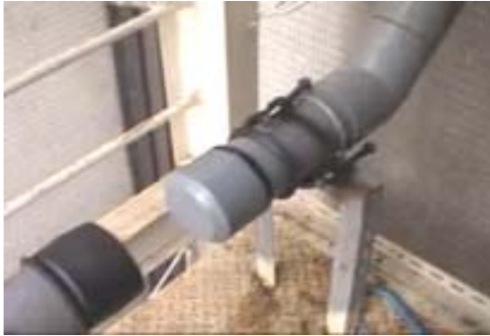
2F 平台的直橫管接頭處拆解密封
