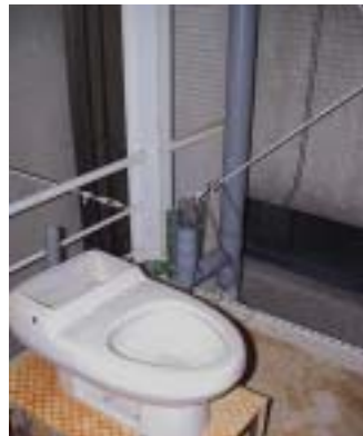
實驗用衛生設備
