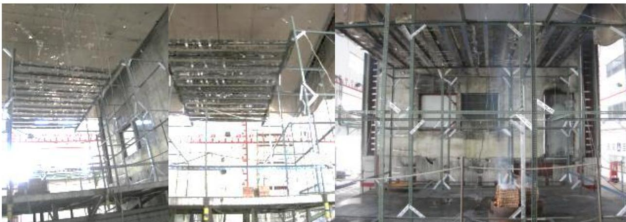
圖 3-12 遮蔽率 80%架設情形
