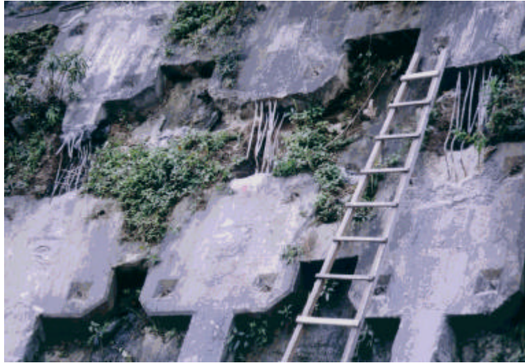
圖 3.5 擋土牆改善工程
