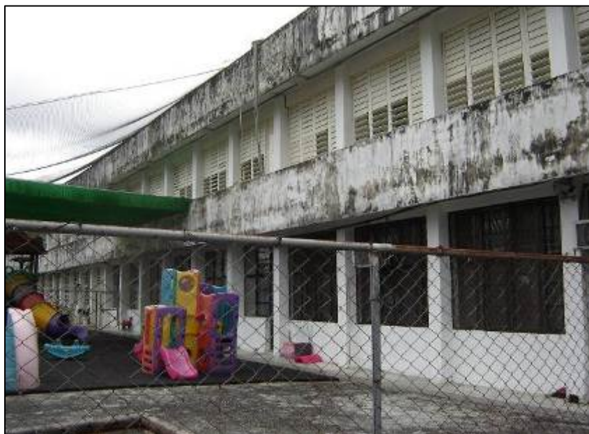
圖 4-4 瑞穗國小 B1 棟背向立面現況圖 (資料來源：立展工程顧問有限公司)
