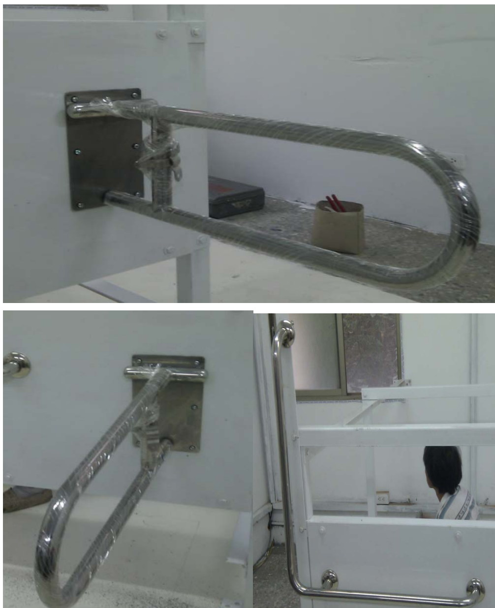
圖 3-12 安裝於補強擴板(鋼板)上之「馬桶上掀式扶手」及「L型扶手」
