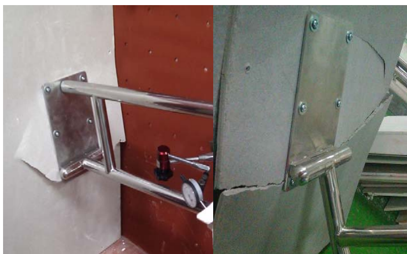
圖 3-5 水泥纖維板承受常態垂直載重試驗所產生之破壞
