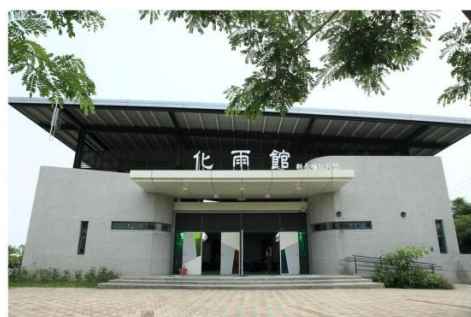
採用自然通風無空調的體育館
