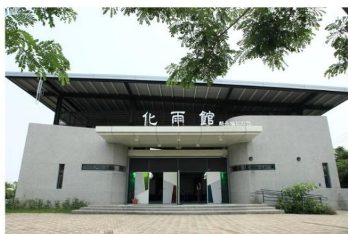
採用自然通風無空調的體育館
