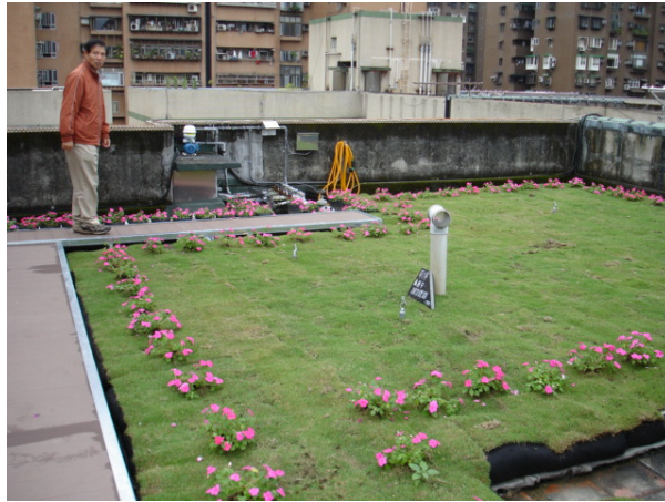
圖 3.31 成功國宅綠屋頂改善 1 資料來源：本研究拍攝
