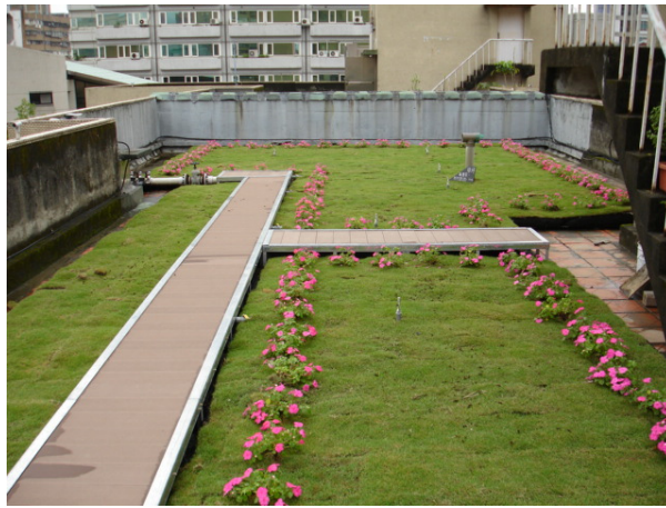
圖 3.32 成功國宅綠屋頂改善 2 資料來源：本研究拍攝
