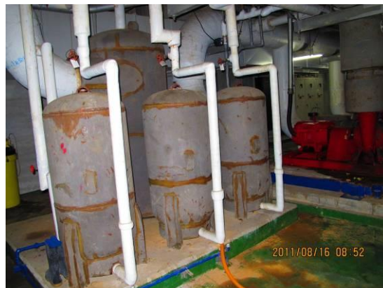
圖55. 自冰水送水管外接管路，進行排水
