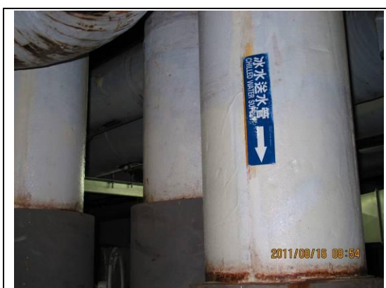
圖52. 自冰水送水管外接管路，進行排水
