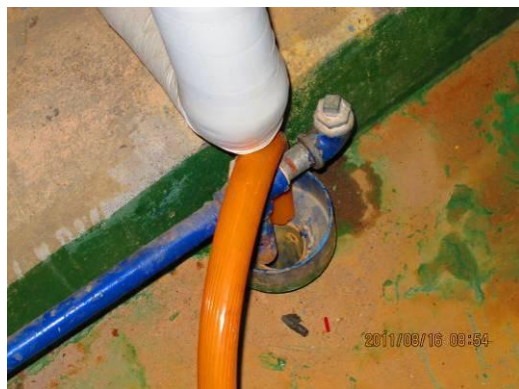
圖56. 自冰水送水管外接管路，進行排水
