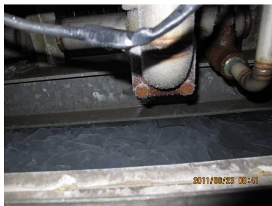
圖55. 自冰水送水管外接管路，進行排水
