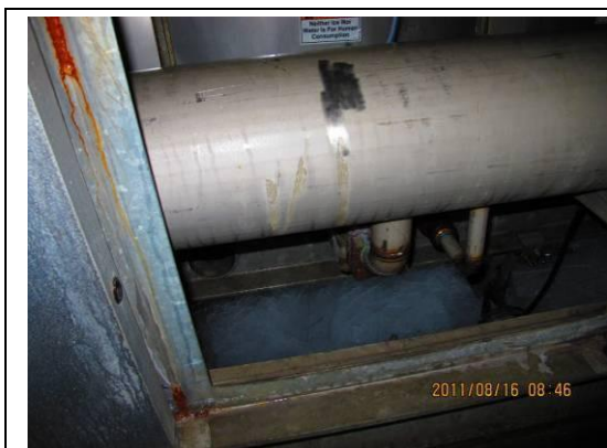
圖50. 改善前儲冰槽儲冰顯示情況
