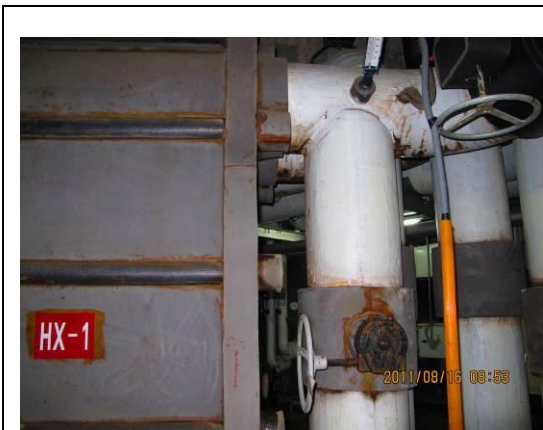
圖54. 自冰水送水管外接管路，進行排水
