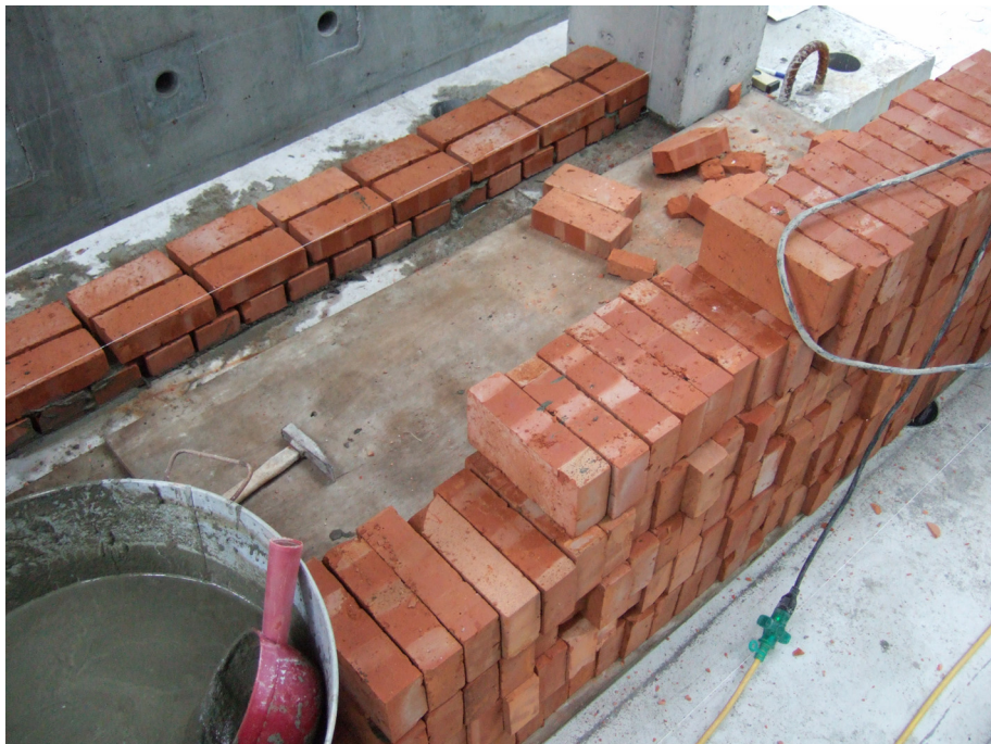
圖 3-22 確認紅磚堆砌方式及水泥砂漿配比
