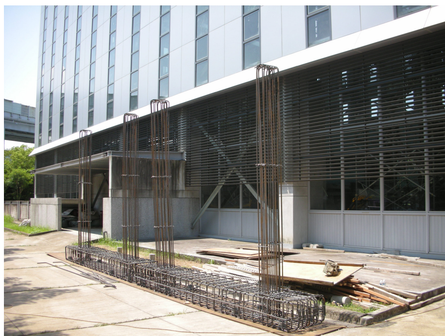
圖 3-12 基礎鋼筋組立
