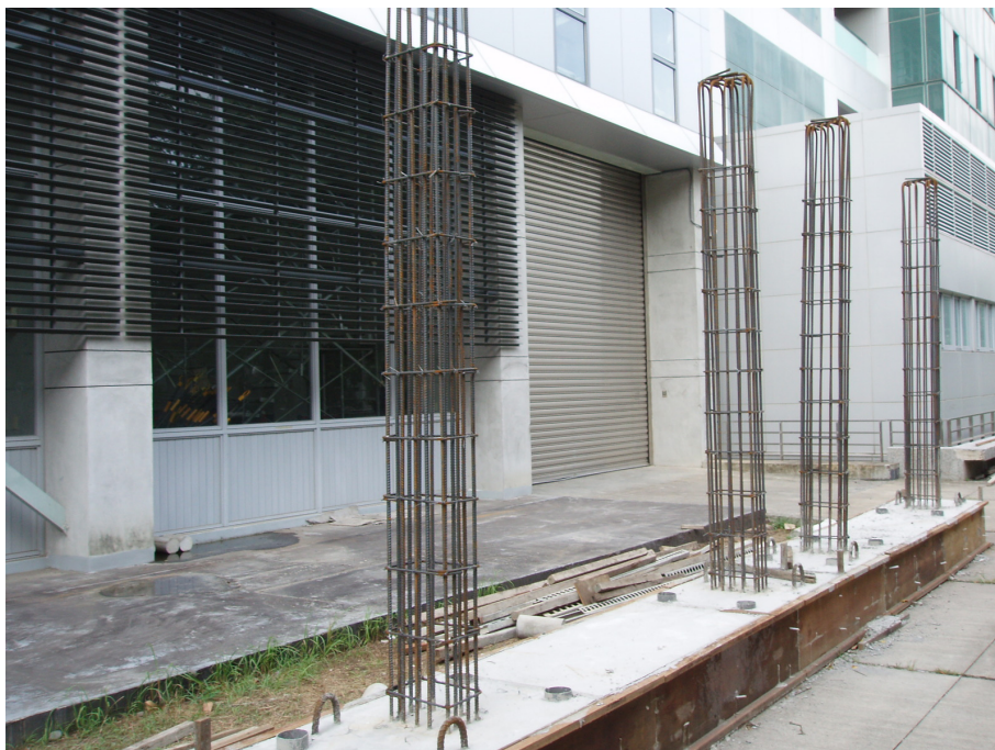
圖 3-16 柱箍筋綁紮完成(間距為 25 公分)
