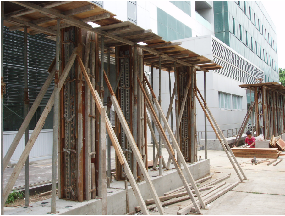
圖 3-17 柱封模板及現場支撐情形
