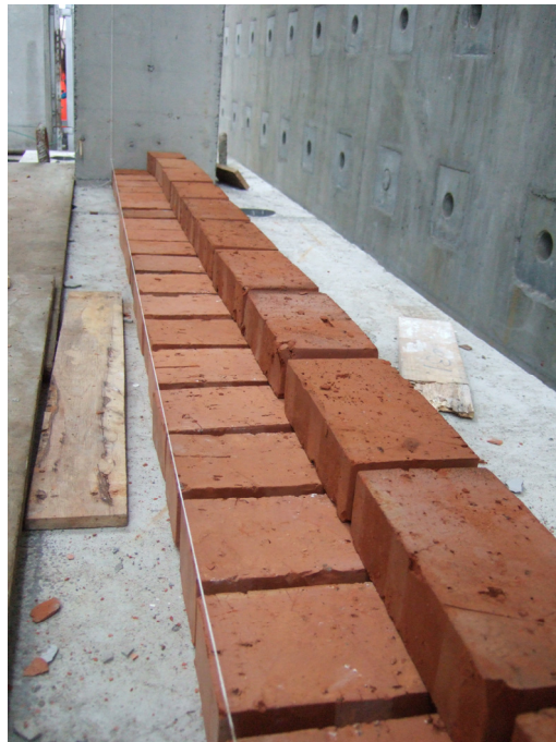
圖 3-10 英式砌法之紅磚堆疊示意圖
