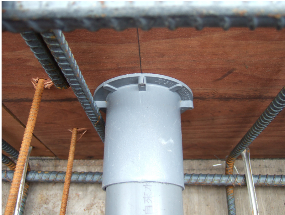
圖 3-19 以專用接頭固定梁之預埋管位置
