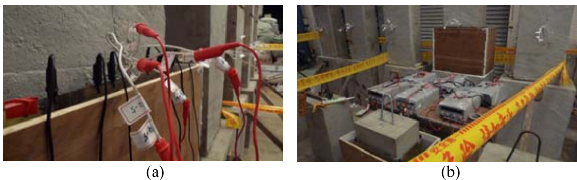
圖 3-14 腐蝕梁實際通電圖：(a)導線連接；(b)整體通電圖
