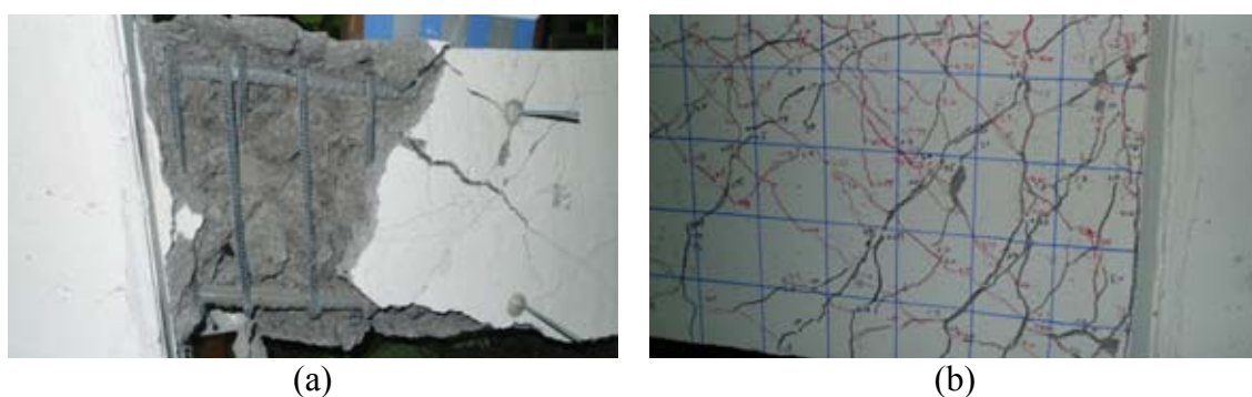
圖 3-49 B t -0 腐蝕試體破壞情況(a)塑鉸區保護層剝落；(b)塑鉸區裂縫分布
