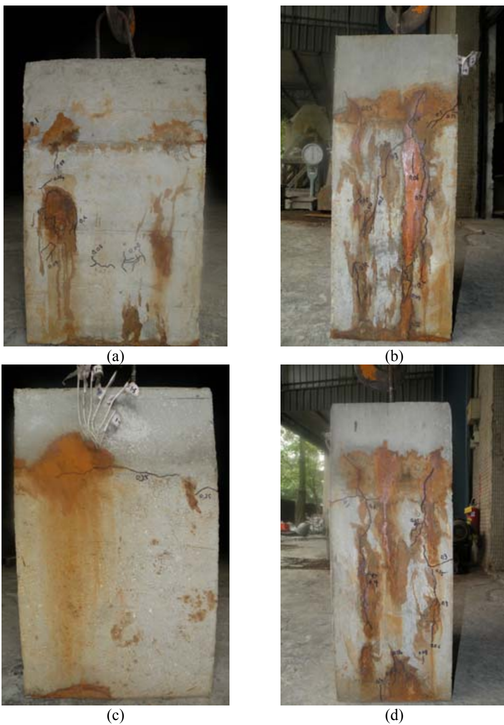
圖 3-21 腐蝕觀察試體橫向鋼筋-重量損失率 6% 試體表面的裂縫發展情況:(a)試體前側; (b)試體左側 ; (c)試體後側 ; (d)試體右側
