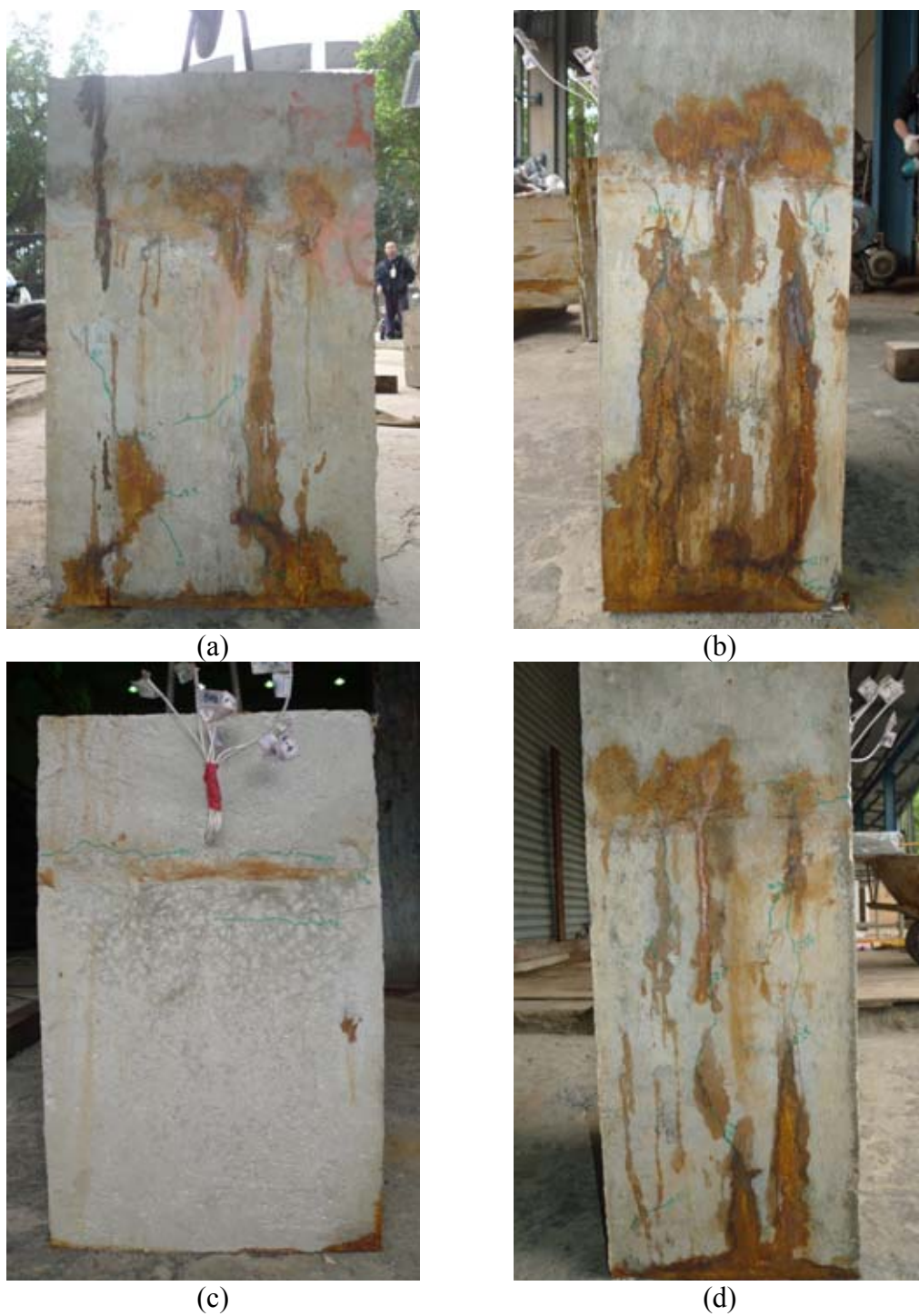
圖 3-25 腐蝕觀察試體橫向鋼筋-重量損失率 12%試體表面的裂縫發展情況：(a)試體前側；(b)試體左側；(c)試體後側；(d)試體右側
