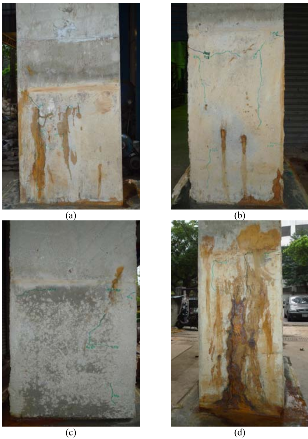
圖 3-26 全尺寸試體橫向鋼筋-重量損失率 12% 試體表面的裂縫發展情況:(a)試體前側； (b)試體左側；(c)試體後側；(d)試體右側
