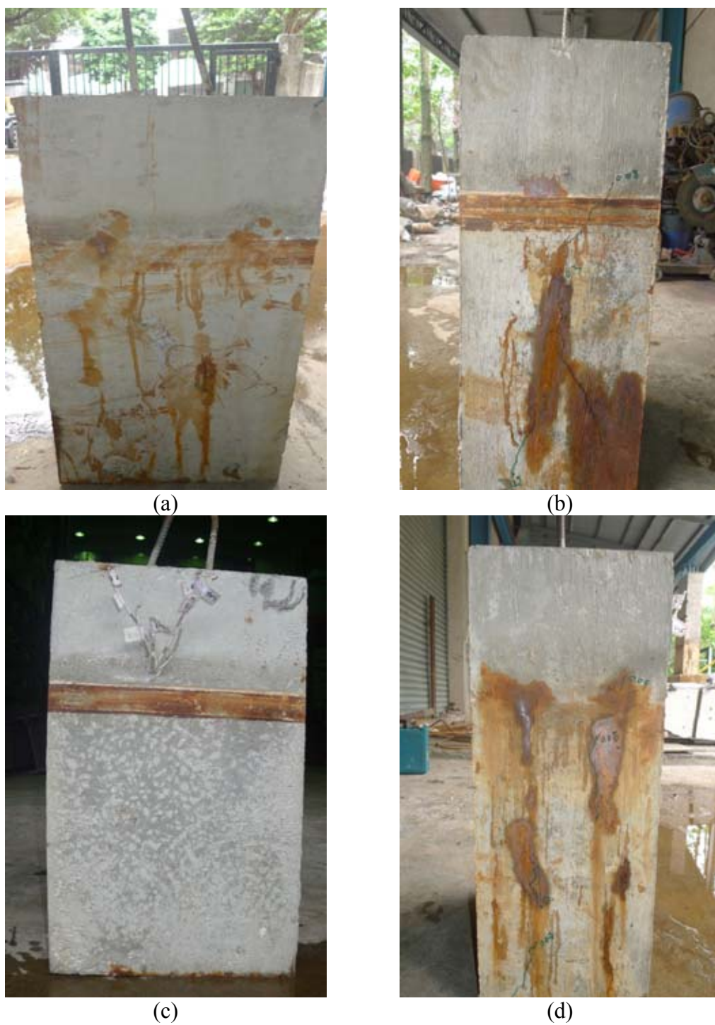
圖 3-19 腐蝕觀察試體橫向鋼筋-重量損失率 3% 試體表面的裂縫發展情況:(a)試體前側; (b)試體左側;(c)試體後側;(d)試體右側
